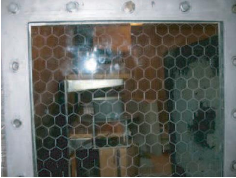
Kuva 4 Lundin yliopiston rakentama testi-ikkuna [22.]
