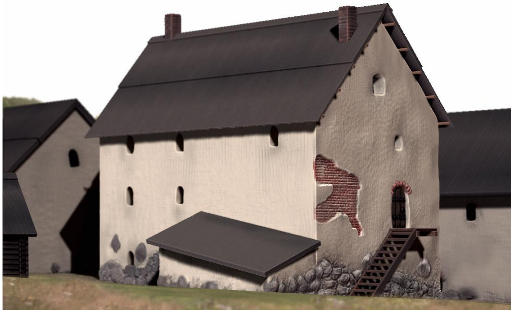
Kuva 39. Rakennus takapihalta tarkasteltuna.
