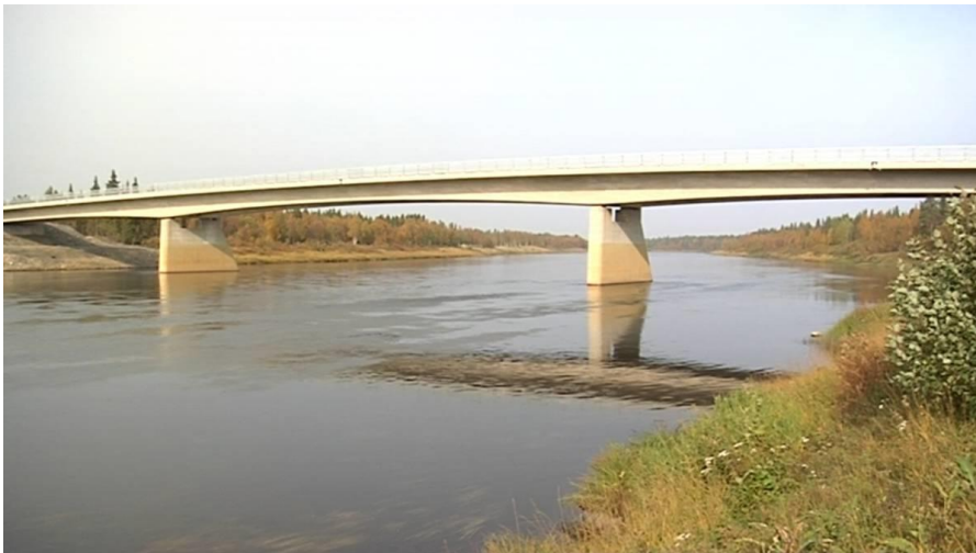
KUVA 1 Kt 79 Kaukosen silta Kittilässä.(7).
