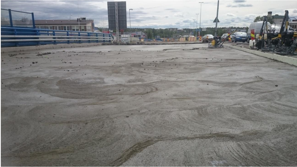
KUVA 10 Osittain hierretty betonointi pinta
