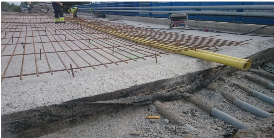
KUVA 7. Kaapeliputket.
