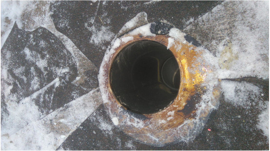
KUVA 8. Holvin rakennusaikainen sadevesiviemäri. (Kuva: Pekka Harmaala 2016)
