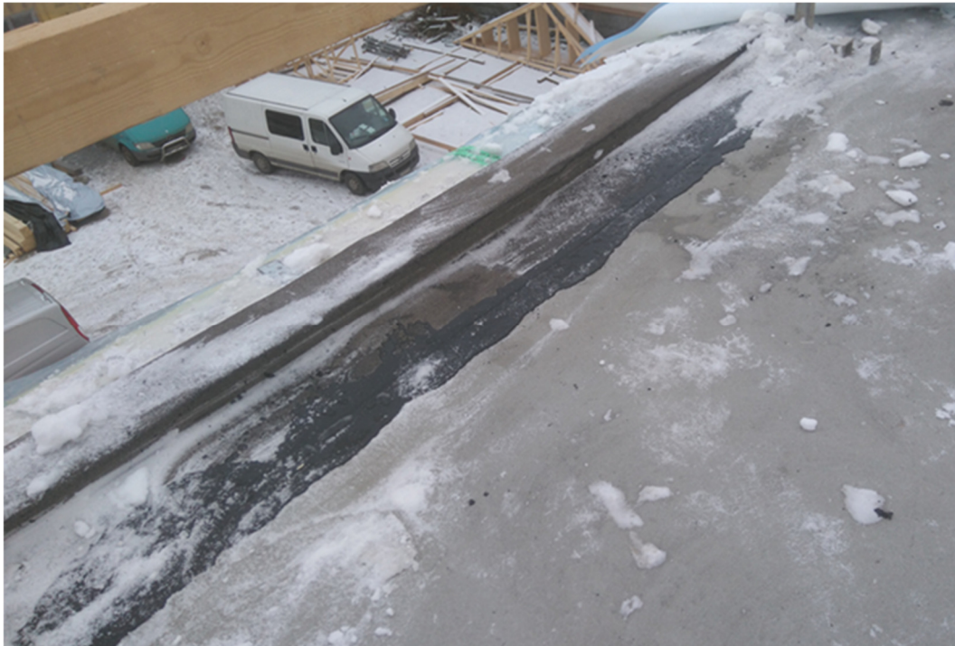
KUVA 5. Holvin reunakehys ja huopa asennettuna päälle. (Kuva: Pekka Harmaala 2016)
