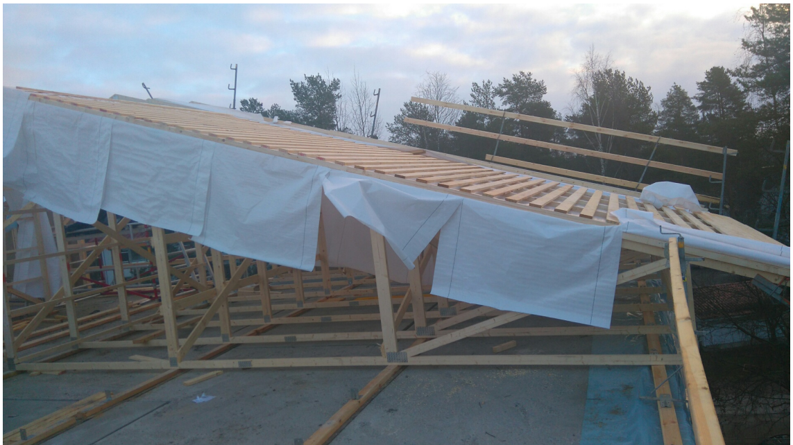
KUVA 2. Vesikattolohko rakennettuna holvilla. (Kuva: Markku Sauvola 2016)
