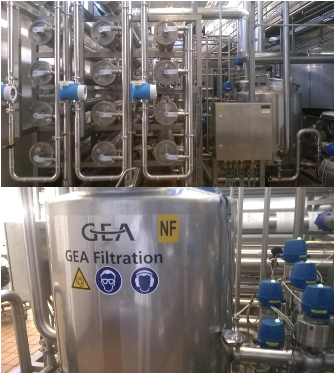
Kuva 4. Nanosuodatuksen 14 putken suodatusyksikkö ja sen alla NF-laitteiston suppilosäiliö.
