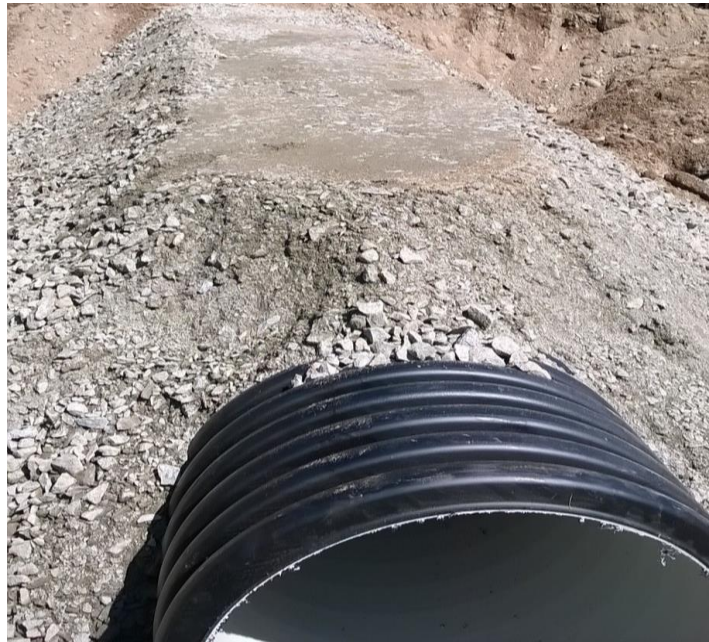
KUVA 2. Rummun ympärystäyttö tehtynä. (kuva Ville Köppä 2016)
