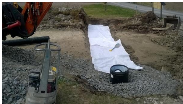
KUVA 1. Arinan alle asennettu suodatinkangas. (kuva Ville Köppä 2016)
