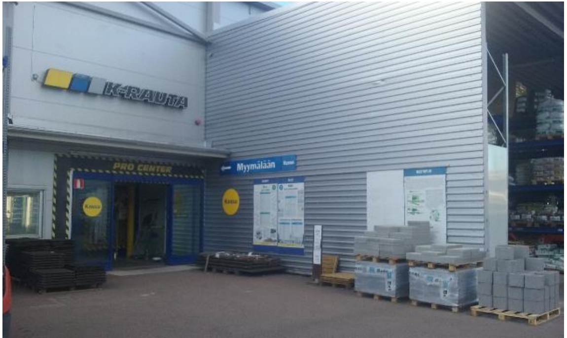
Kuva 6. Myymälään menevän oven edustan kattamalla saataisiin lastaussuojaa asiakkaille
