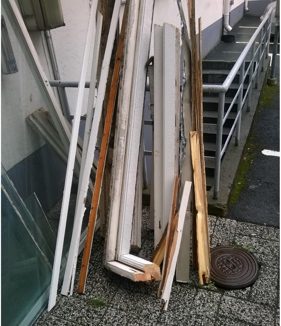
Kuva 13. Vanhan ikkunan puuosat irrotetaan pätkissä, jotta ei rikottaisi ympäröiviä rakenteita. (J.-P. Tuominen, henkilökohtainen tiedonanto 1.9.2016).
