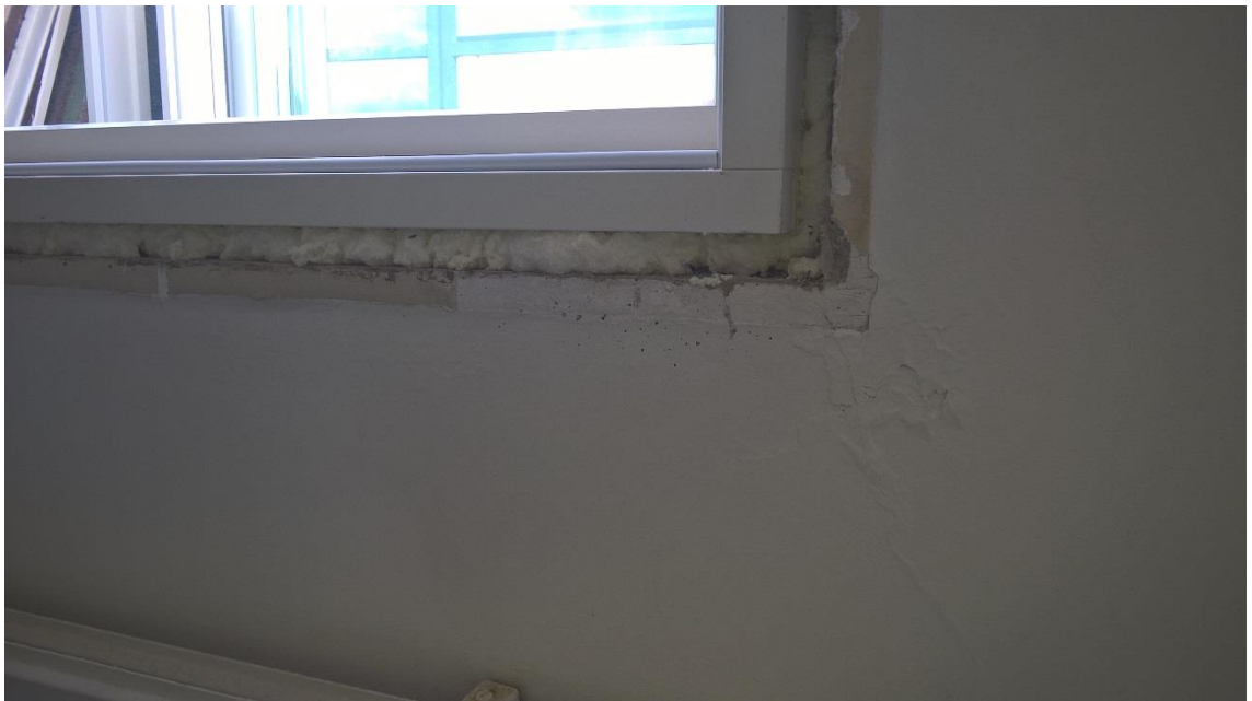
Kuva 19. Eristysväli täytettynä uretaanilla (J.-P. Tuominen, henkilökohtainen tiedonanto 1.9.2016).
