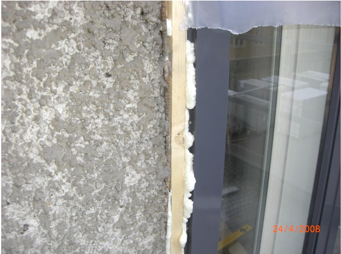
Kuva 16. Lauta apukarmina, kun vanhoja kiinnityskohtia ei ollut (J.-P. Tuominen, henkilökohtainen tiedonanto 1.9.2016).
