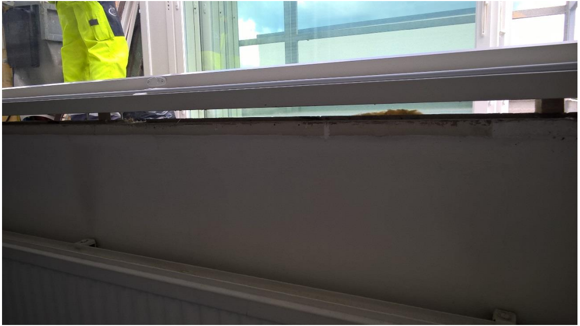
Kuva 18. Eristysväli tyhjänä (J.-P. Tuominen, henkilökohtainen tiedonanto 1.9.2016).
