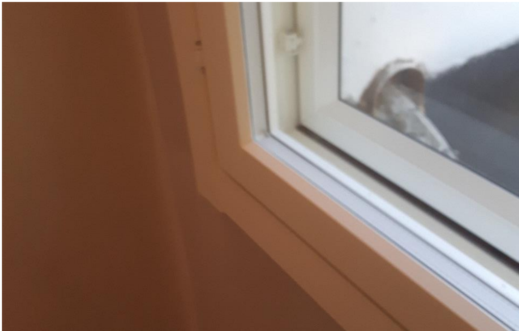
Kuva 22. Uusi ikkuna ja listoitus porrashuoneessa. Karmisyvyys suurentunut.
