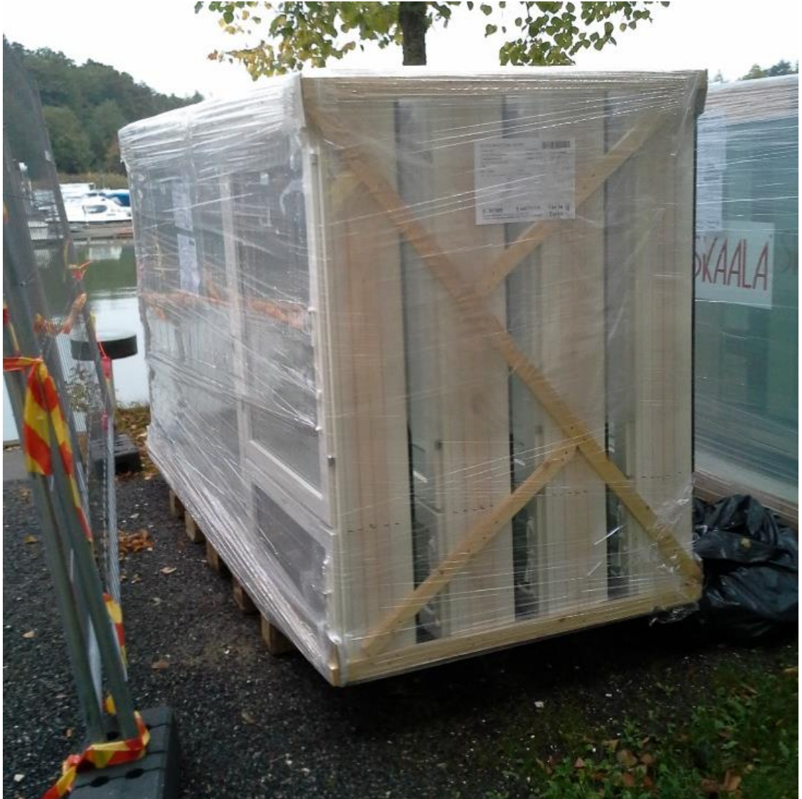
Kuva 4. Tehdasmuovi on tarkoitettu vain lyhytaikaista varastointia varten, ja ikkunapaketit tulisi aina suojata lisäksi erillisillä pressuilla.
