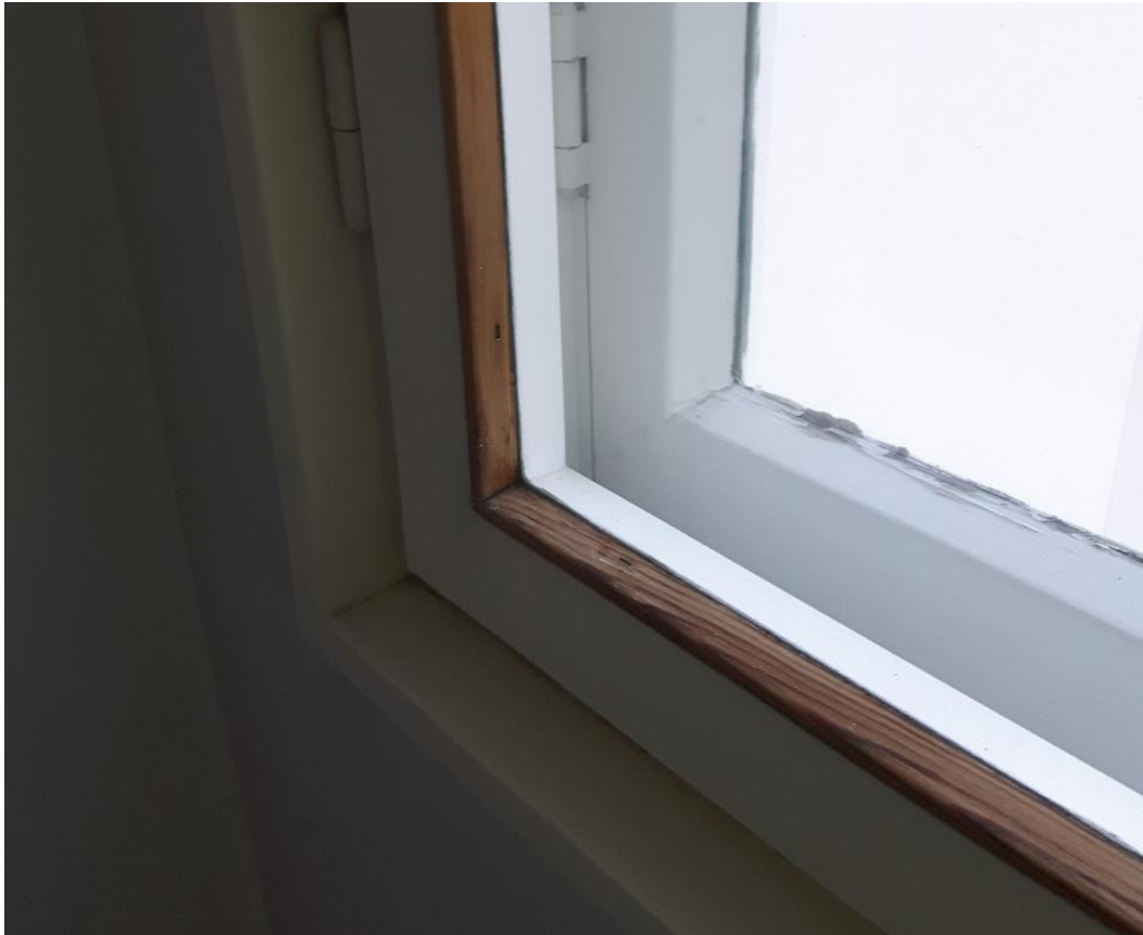
Kuva 21. Vanha ikkuna ja listoitus porrashuoneessa.
