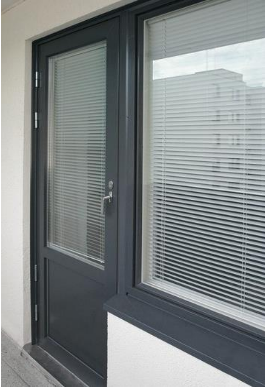
Kuva 12. Malliasennuksessa listoitetaan myös ulkopuoli valmiiksi (Onnistunut ikkuna- ja oviremontti asukkaiden ehdoilla 2015).
