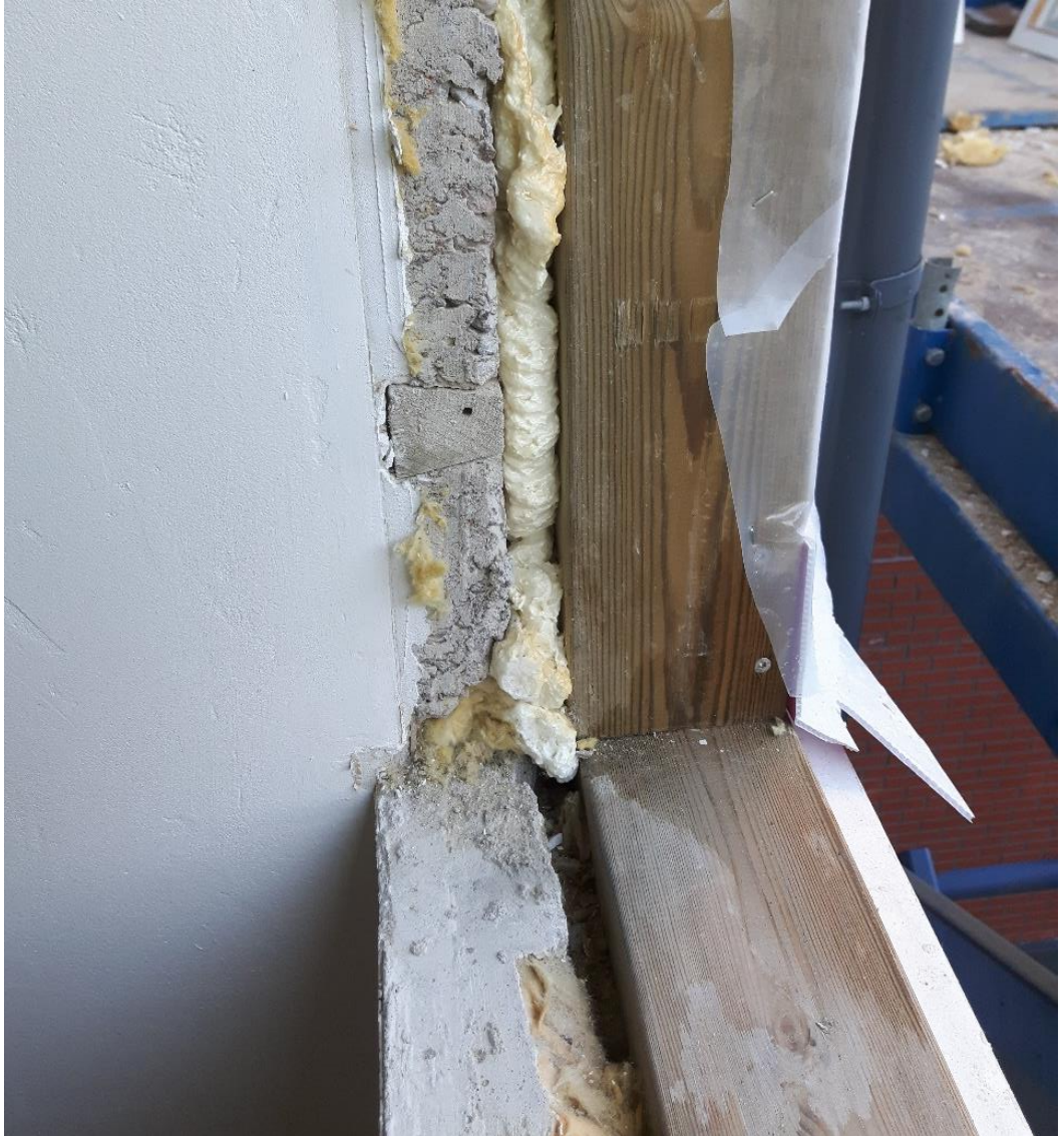
Kuva 14. Ikkuna-aukko vanhan karmin purun jälkeen.
