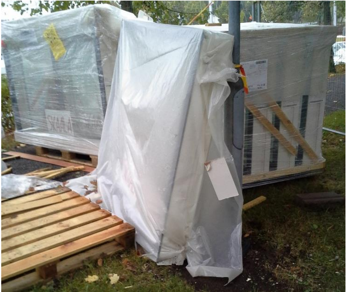
Kuva 5. Ikkunan vääränlainen säilytys vahingoittaa puuosia.
