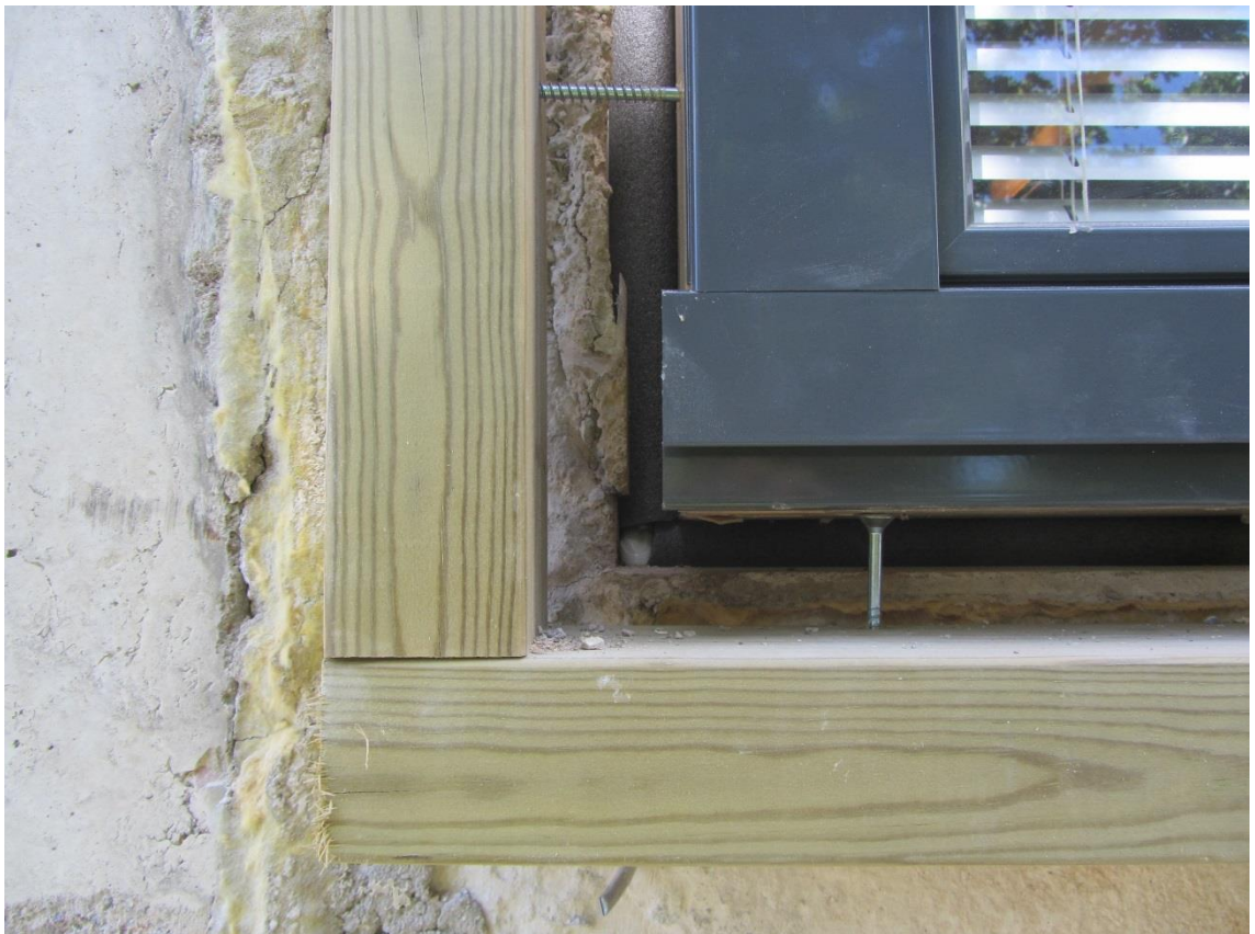
Kuva 15. Ikkunakarmin sivukiinnitys ja alakarmin tasoruuvi (J.-P. Tuominen, henkilökohtainen tiedonanto 1.9.2016).
