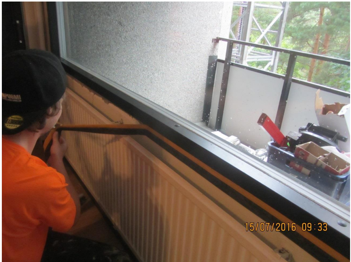
Kuva 20. Ikkunasauman teippaus ilmatiiviiksi uretaani-eristyksen jälkeen (J.-P. Tuominen, henkilökohtainen tiedonanto 1.9.2016).
