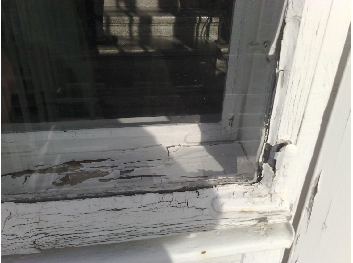
Kuva 8. Lahaa ikkunan ulkopuitteessa (J.-P. Tuominen, henkilökohtainen tiedonanto 1.9.2016).
