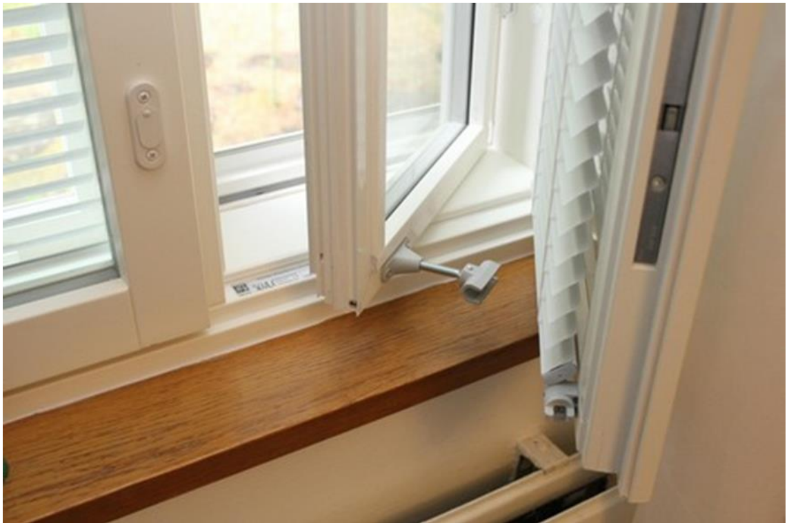
Kuva 10. Tuuletusikkunan aukipitolaite avattuna. (Onnistunut ikkuna- ja oviremontti asukkaiden ehdoilla 2015)
