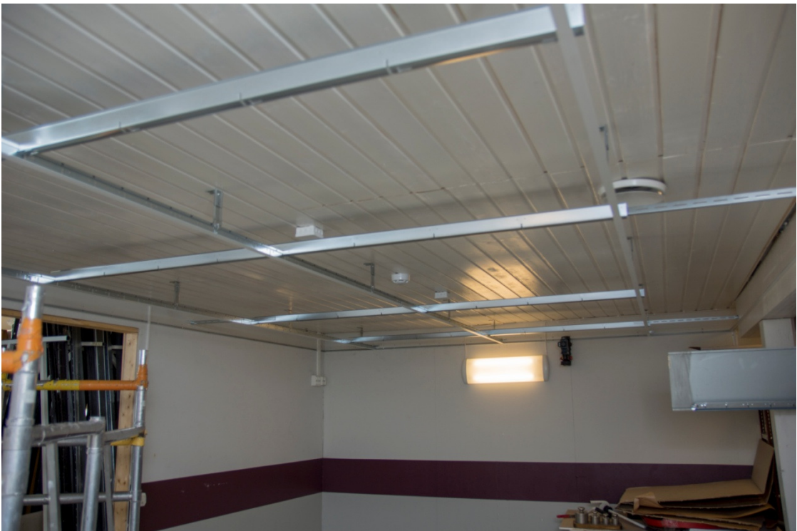
KUVA 25. Etäisyystangot asennettuna ja sidottuna vastakkaisiin seiniin
