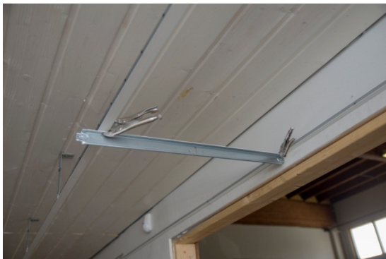
KUVA 21. Pääkannattimen aseman väliaikainen lukitus
