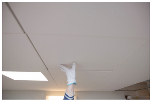
Kuva 30. 2. vaihe levyn asennuksessa
