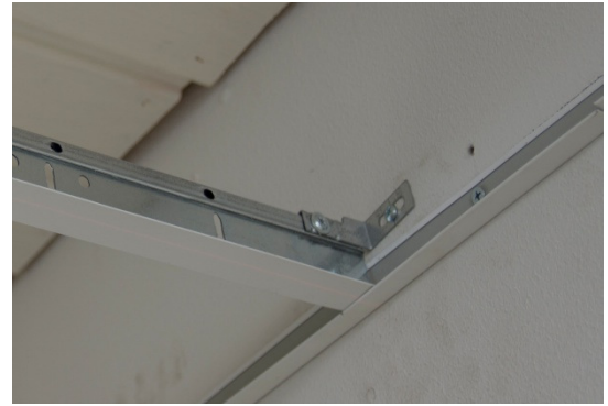
KUVA 18. Pääkannattimen päädyn kiinnitys
