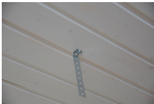
KUVA 15. Reikänauha asennettuna
