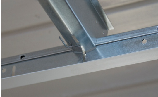
KUVA 23. Etäisyystangon kiinnitys pääkannattajaan
