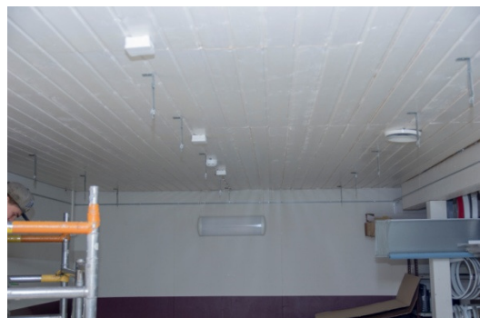
KUVA 16. Valmis ripustuskenttä
