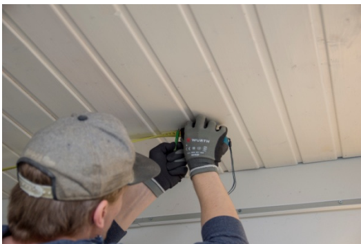
KUVA 13. Ripustinlinja mittaus
