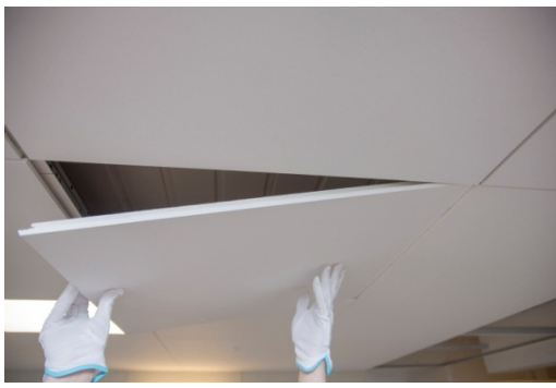
Kuva 29. 1. vaihe levyn asennuksessa
