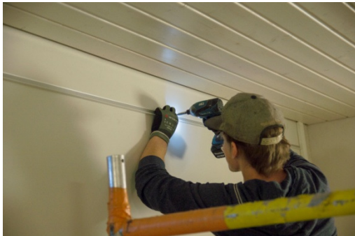
KUVA 8. Listan kiinnitys
