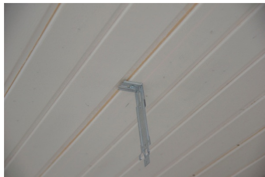
KUVA 14. SKI-kiinnike asennettuna
