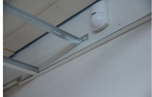
KUVA 24. Etäisyystangon seinäkiinnitys
