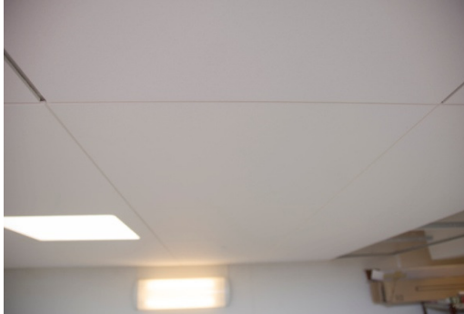
Kuva 31. 3. vaihe levyn asennuksessa
