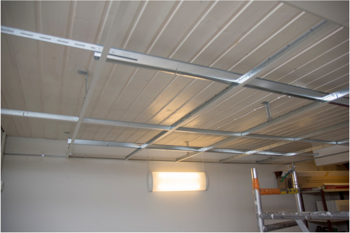
KUVA 26. Välilistat asennettuna ensimmäisen täyden levyn jälkeen
