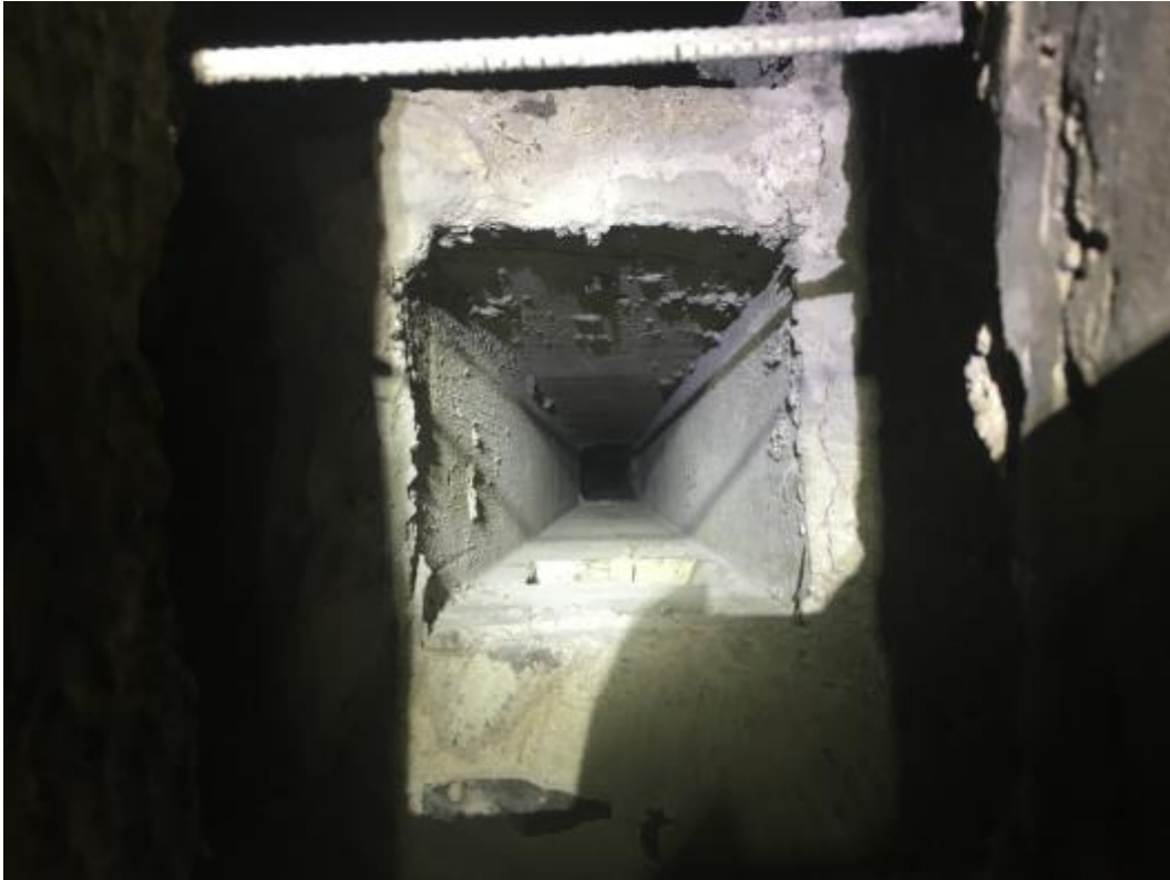
Kuva 5. 1960-luvun betoninen ilmahormi puhdistettuna.
