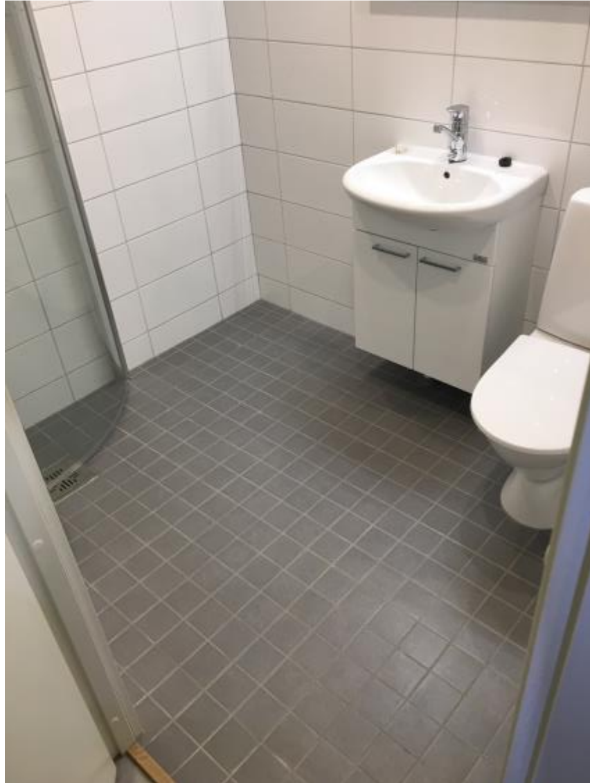
Kuva 18. Perinteisen linjasaneerauksen yhteydessä laajennettu kylpyhuone ja vesikalusteiden uudelleen järjestely. Pyörähdysympyräksi saatiin 1300 mm ja kynnyks pienemmäksi ja ovi vaihdettiin 9 moduulin leveyteen.
