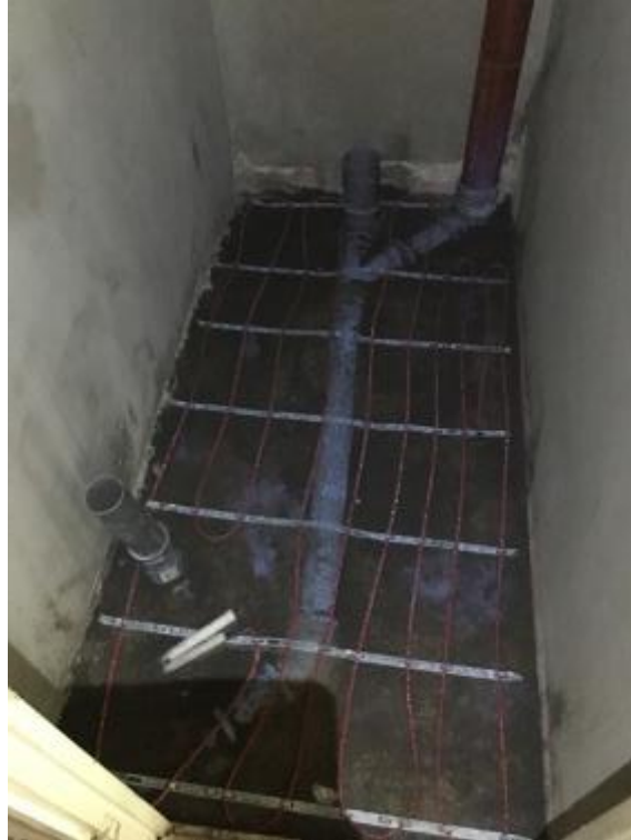
Kuva 9. Muoviviemärillä tehty wc-kopin viemärit. Tuuletusviemäriin osuus muutettu valuraudaksi.
