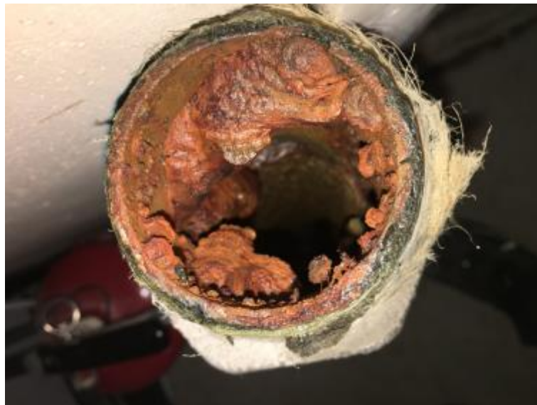
Kuva 2. Vuonna 1962 rakennetun kerrostalon kylmän käyttöveden putki.
