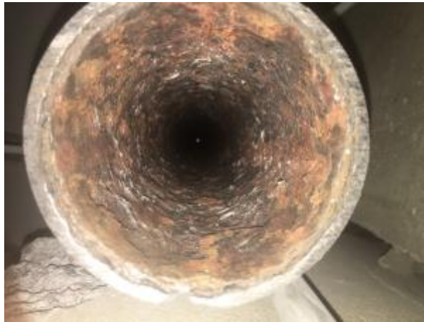
Kuva 11. Viemäri ennen pinnoitusta.
