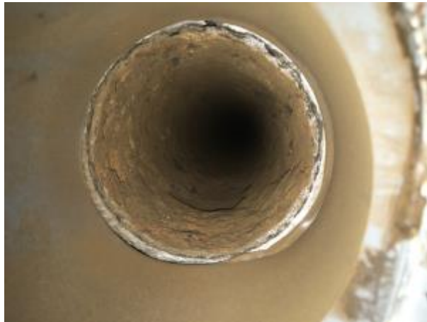
Kuva 12. Viemäri puhdistettuna mekaanisesti.
