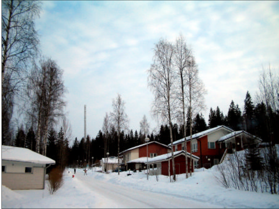
Kuva 29. Katajaharjun gsm-masto kuvattuna Marttilankadun päästä.
