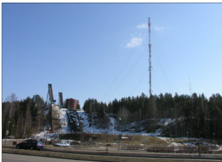
Kuva 6. Harustettu masto lähellä Kouvolan keskustaa.
