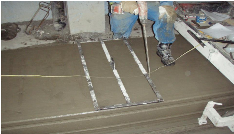
Kuva 20. Vesireikien poraus tehtaalla.
