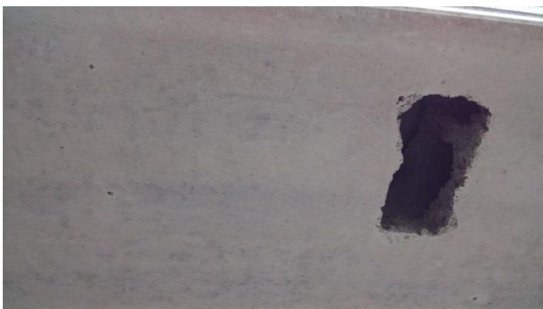
Kuva 30. Reiän jälkeen poratut vesireiät.
