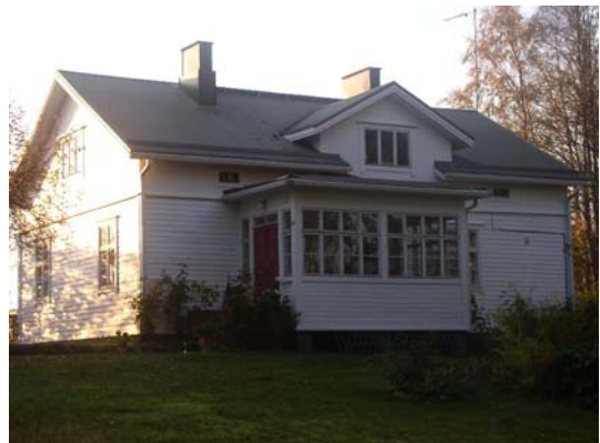
ja maalauksen jälkeen.
