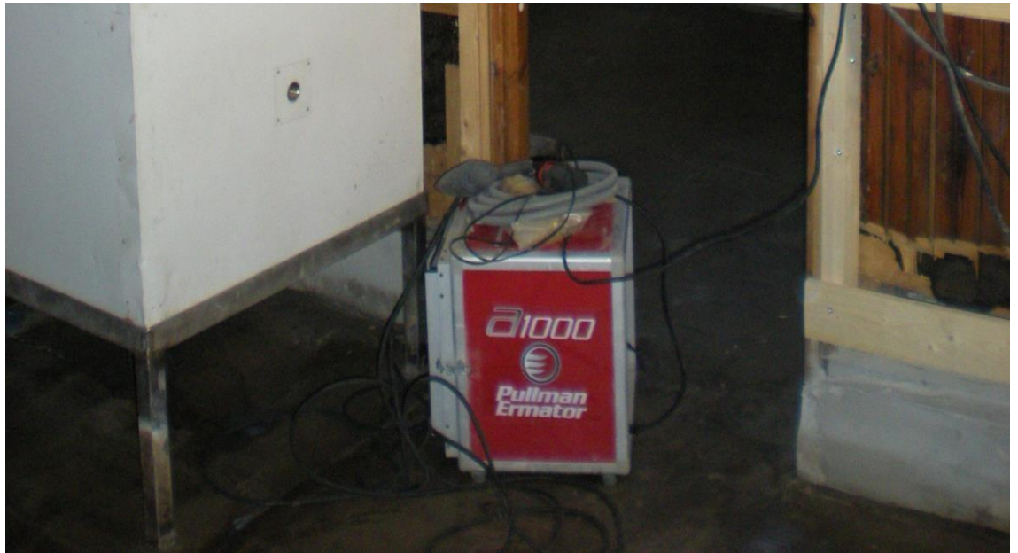
KUVA 14. Rantasaunalla käytettiin Pullman Ermator a1000-ilmanpuhdistinta. (Kuva: Juha Taipainen. 2016)
