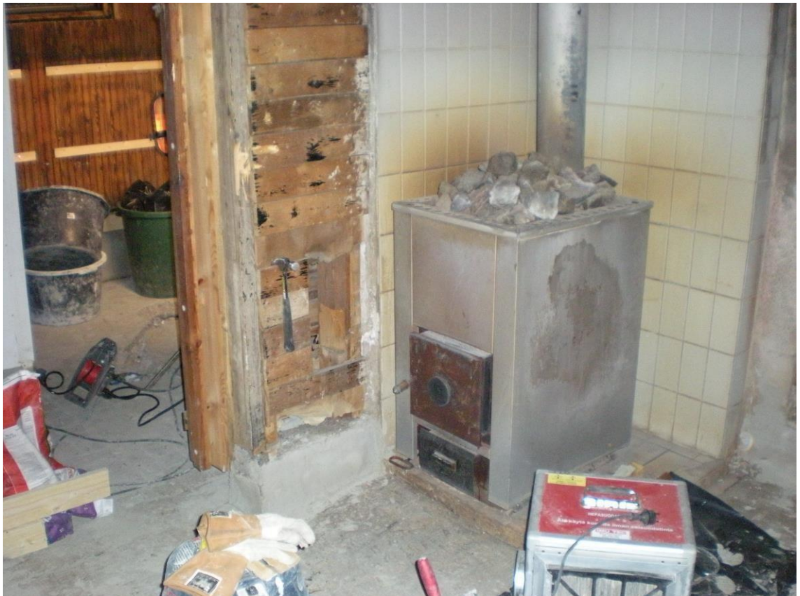
KUVA 8. Miesten puolen kiuas ja taustalla pesuhuoneen seinää uusine koolauksineen. (Kuva: Juha Taipalinen. 2016)
