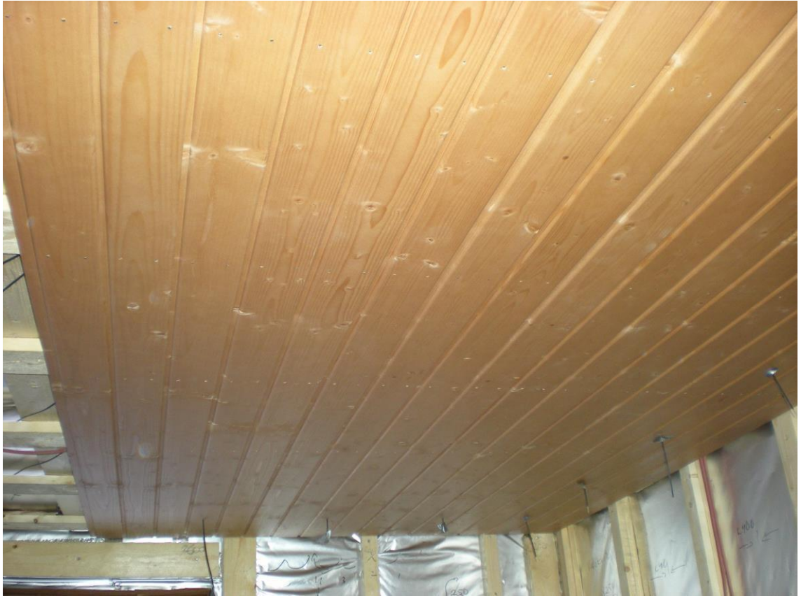
KUVA 11. Katon panelointi aloitettu miesten puolen saunassa. (Kuva: Juha Taipalinen. 2016)
