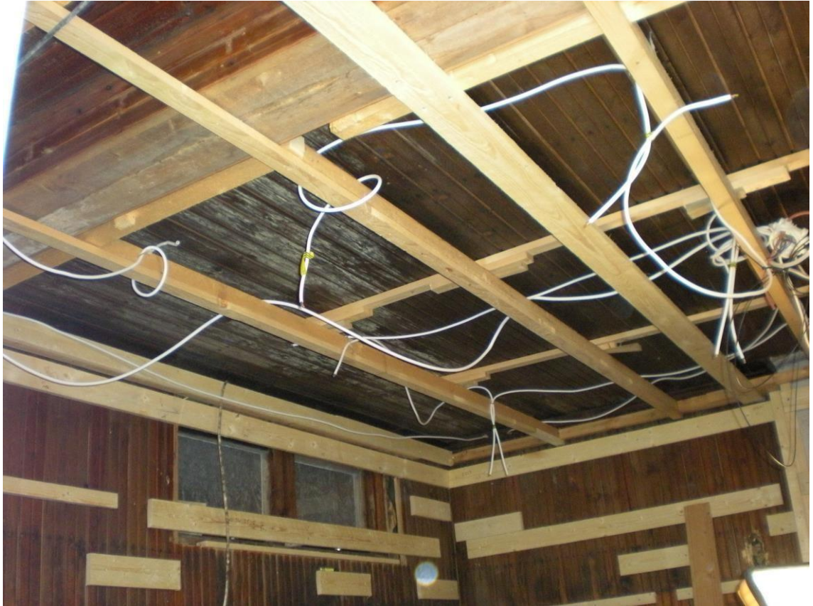
KUVA 12. Miesten pesuhuoneen katon uutta johdotusta. (Kuva: Juha Taipalinen. 2016)
