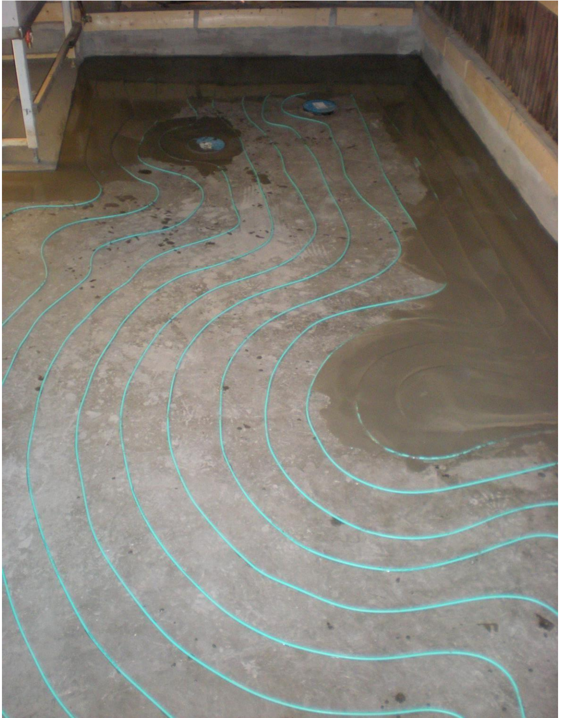
KUVA 10. Naisten pesuhuoneessa lattialämmityskaapelia asennettuna ja tasoitteen levitys menossa, tummat kohdat kuvassa lattialämmitystasoitetta. (Kuva: Juha Taipainen, 2016).
