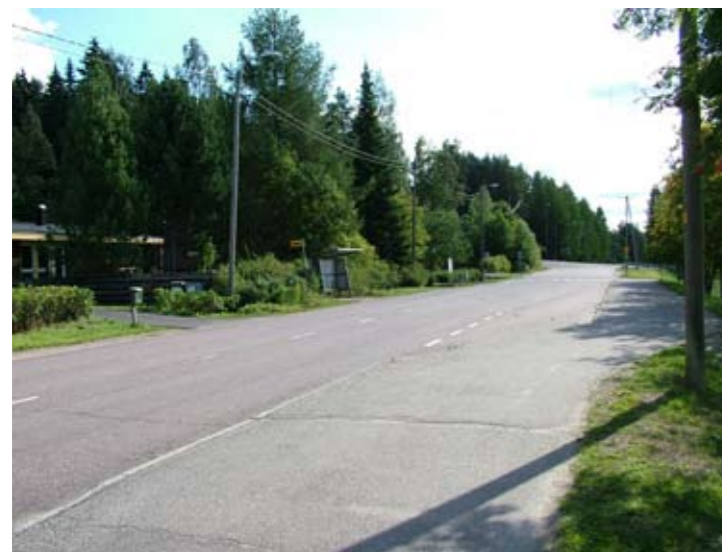
Kuva 120. Koulun julkisenliikenteen pysäkki pohjoiseen
