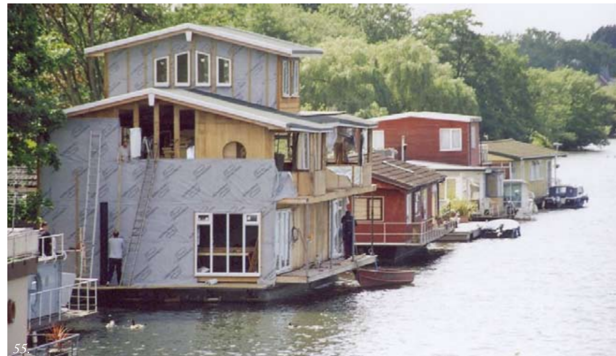
Kuva 55. Kuvassa, kuten kuvassa 48, on kelluvien talojen alue, jossa talo rakenteilla ( www.afloat.org.uk 2007)
