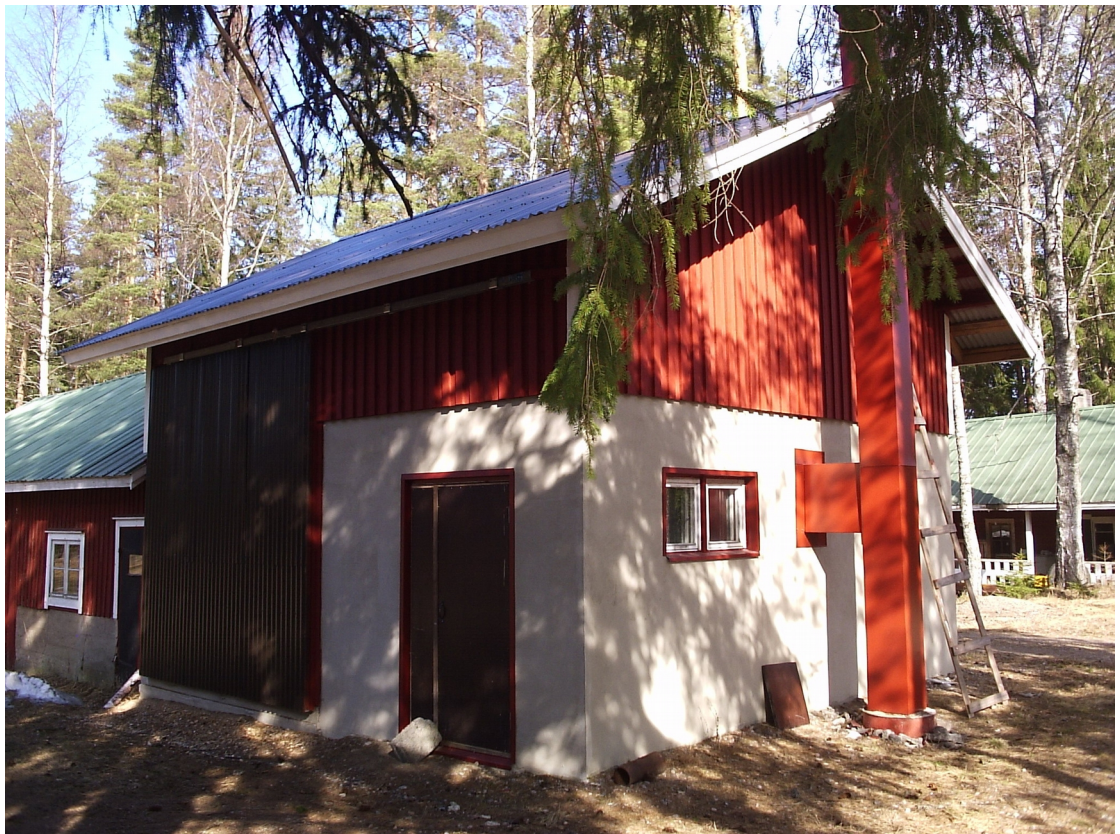
KUVA 14. Vanhan navetan pätyyn rakennettu lämpökeskus
