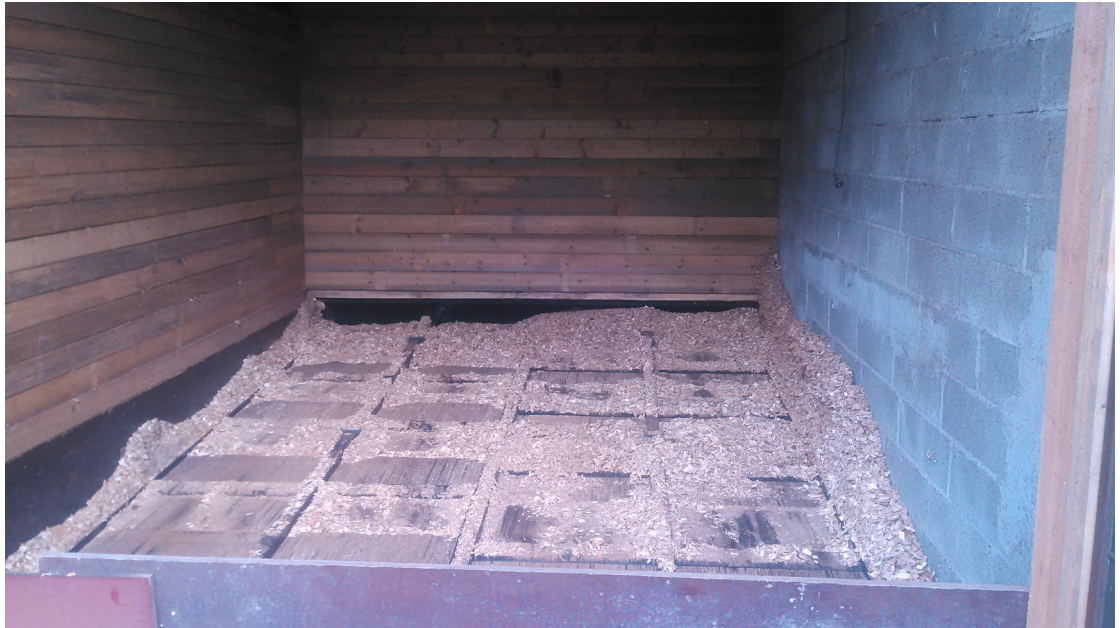
KUVA 17. Hakevaraston pohjalla olevat tankopurkaimet. Seinän alareunassa on rako, josta hake putoaa ruuville
