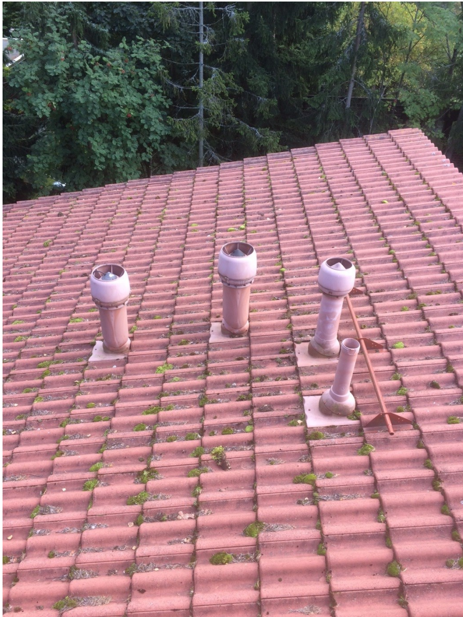
Kuva 28. Testikatto kevyen harjauksen jälkeen
