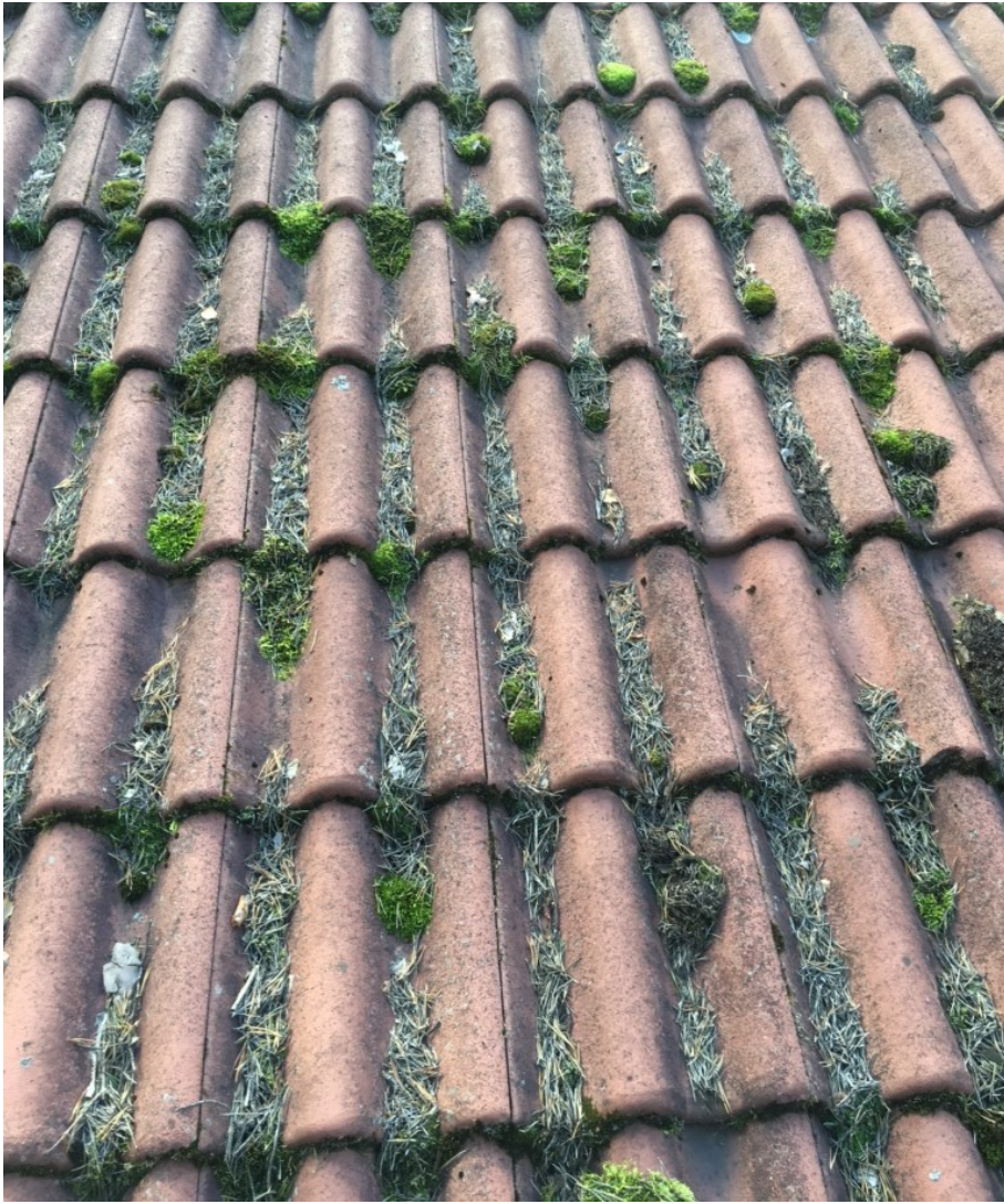
Kuva 27. Testikohteen kattoa ei ollut pesty tai harjattu ikinä aiemmin, kuva otettu 2.7.2016
