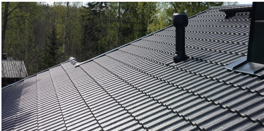
Kuva 1. Ormax Protector –betonikattotiilen lakkaa sisältävä kiiltävä maalipinta hylkii tehokkaasti likaa ja kasvillisuutta
