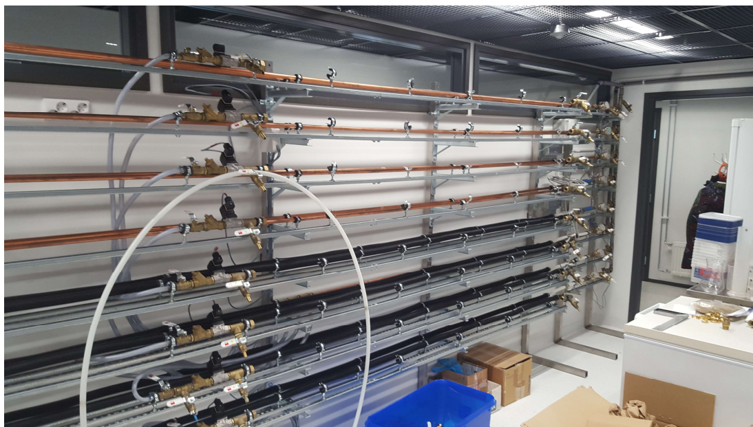
Kuva 8 Laboratorion vesijohdot
