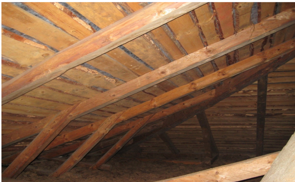
Kuva 3 Katon pohja rakenne on erinomaisessa kunnossa. Vanhan kateen purkaminen olisi rakenteitten puolesta turvalista
