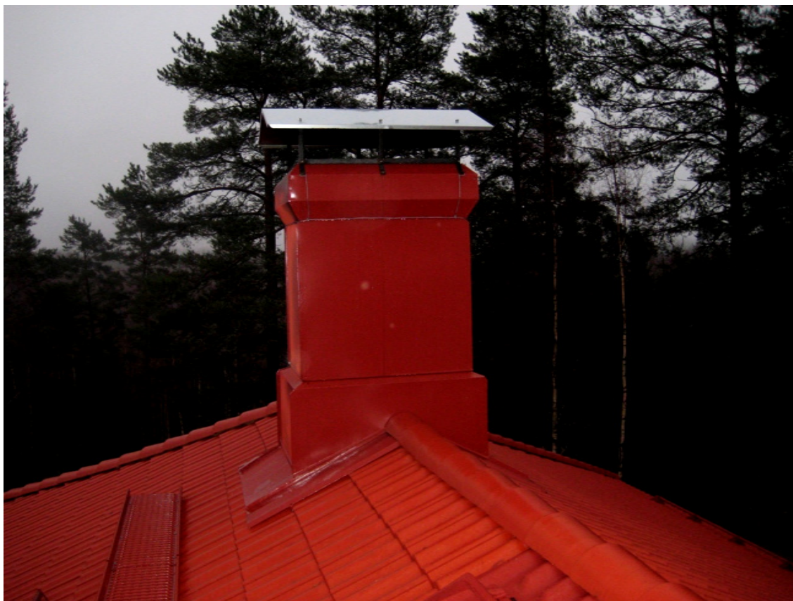
Kuva 11. Ihailtavaa peltisepän ammattitaitoa. Sadekatoksina käytettiin 0.6 mm ruostumatonta terästä
