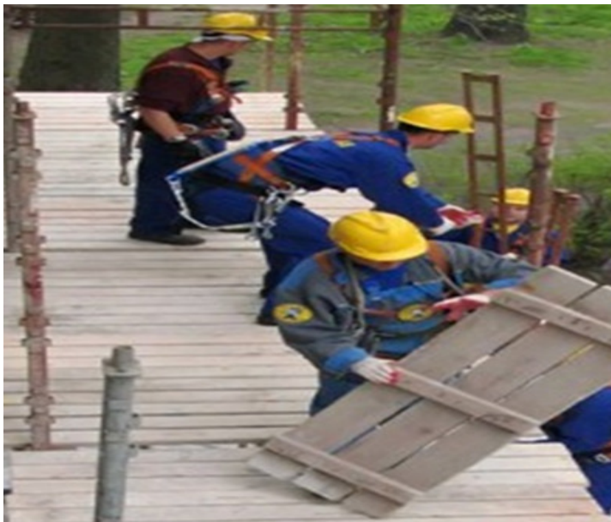
Kuva 4 Telineiden teko on työturvallista ja tehokasta, kun rakennusammattimiehiä on riittävästi
