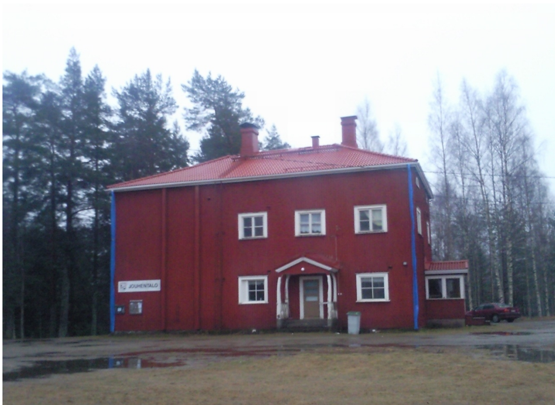
Kuva 12 Syöksyt asennetaan seuraavana keväänä ulkoverhousremontin yhteydessä.
