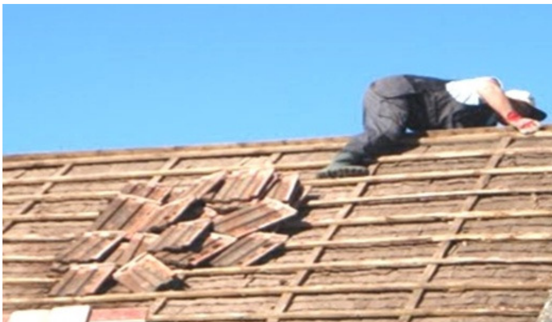
Kuva 5 Tiilet täytyy purkaa käsin
