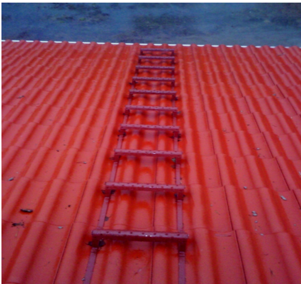
Kuva 9 Katon tikasaskelmat asennettuina
