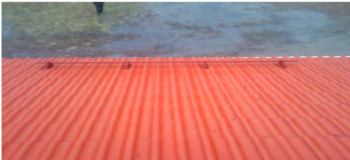
Kuva 7 Lumieste asennettuna räystäälle
