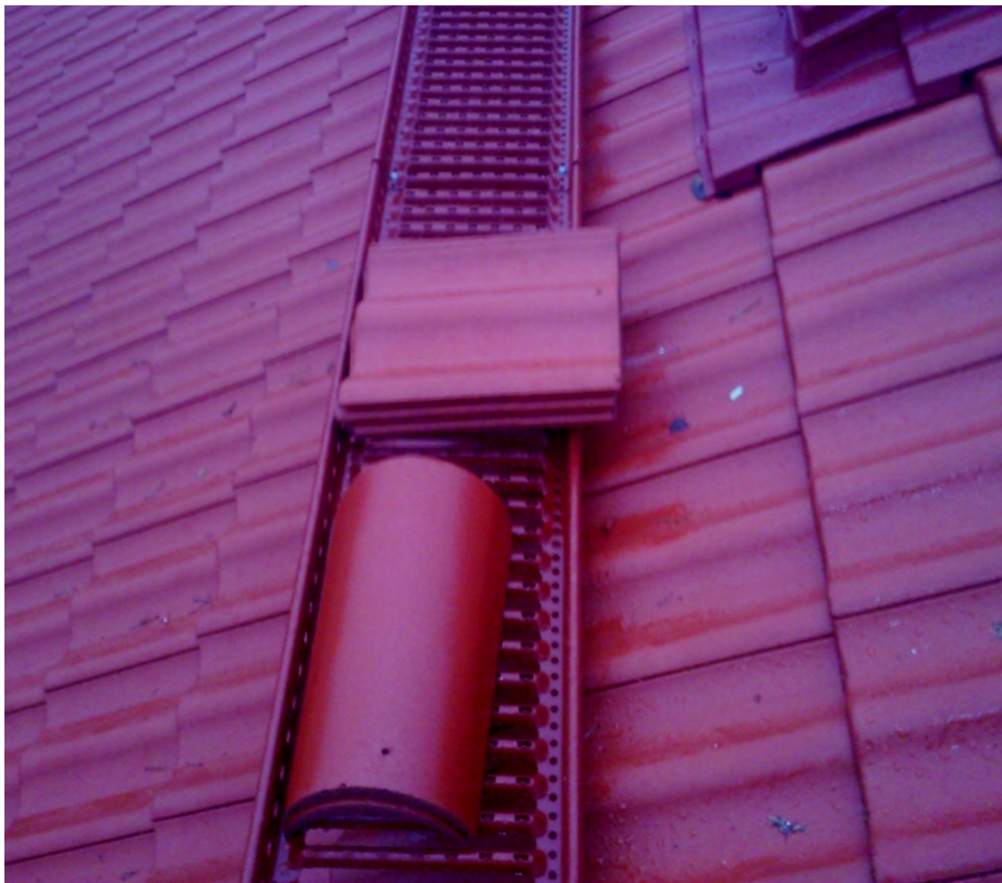
Kuva 10 Kattosilta asennettuna
