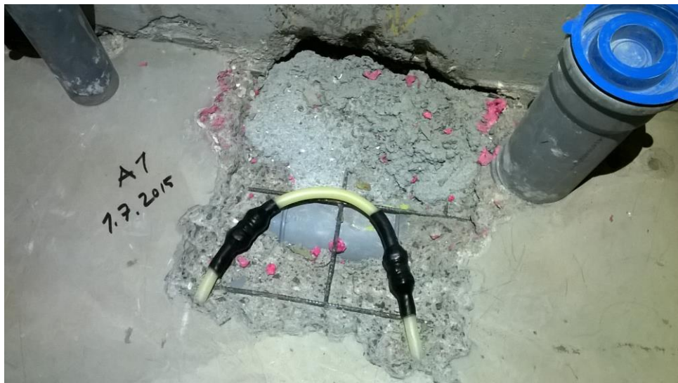
Kuva 13. Kuvassa paikattu lattian vesikiertolämmitysputki. [13]
