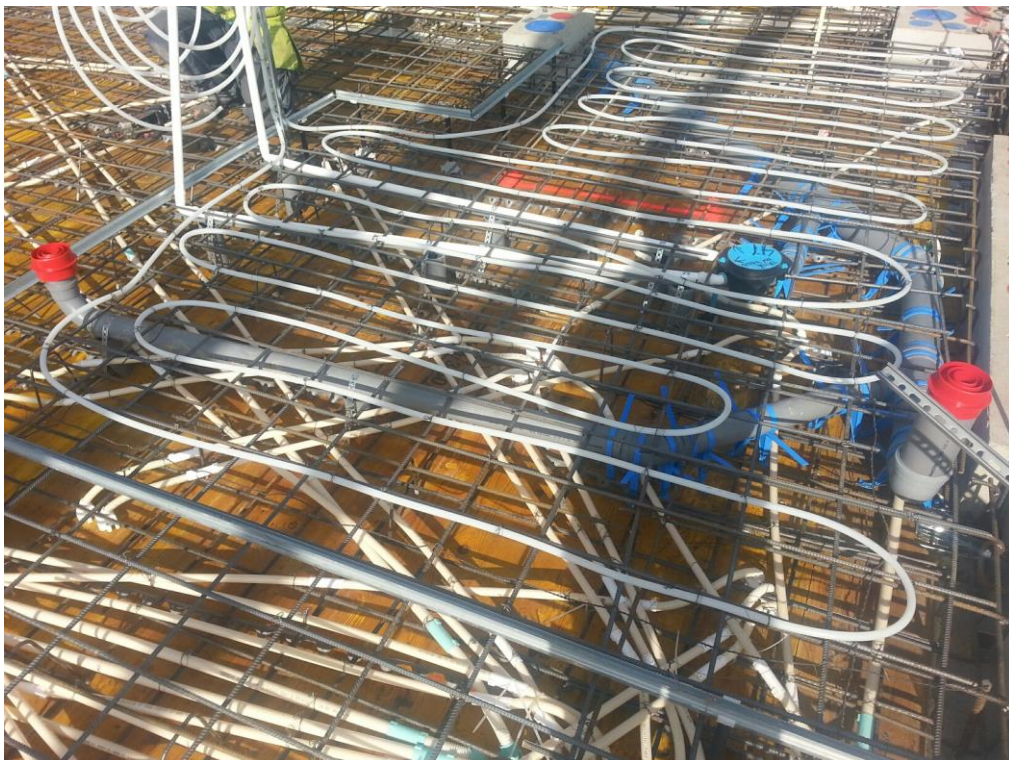
Kuva 11. Talotekniikka valmiiksi tehtynä paikallavaluholvin kylpyhuoneessa. [13]
