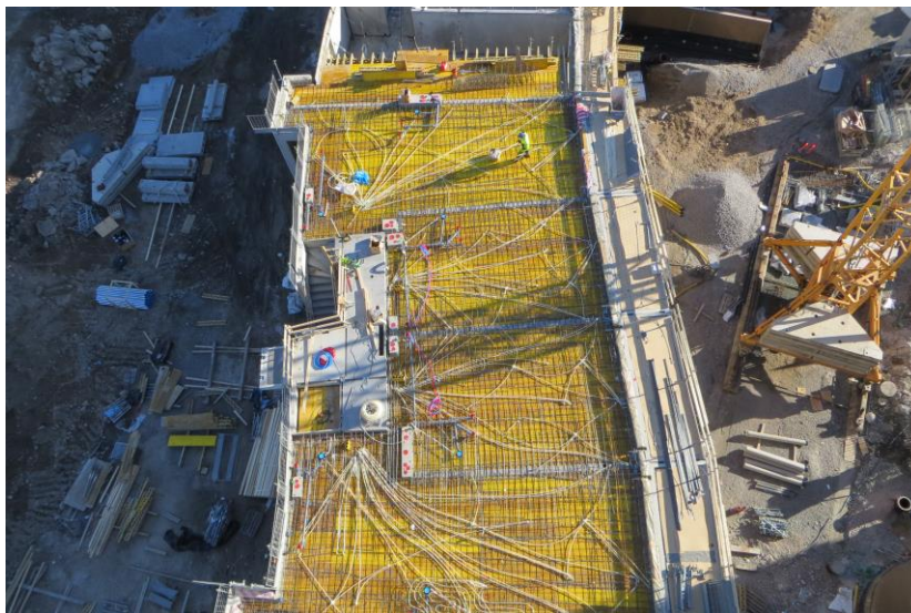
Kuva 16. Kokonaisen kerroksen paikallavaluholvityöt käynnissä. [13]
