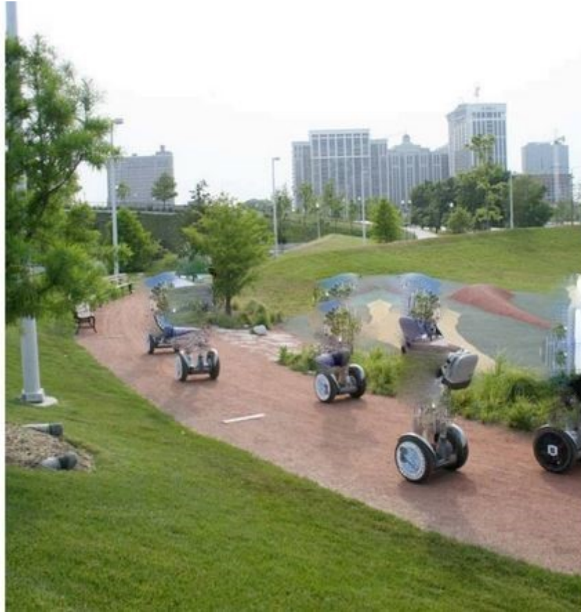
Kuva 2. Stabilizer-aineella valmistettu käytävä (Stabilizer Solutions 2008).
