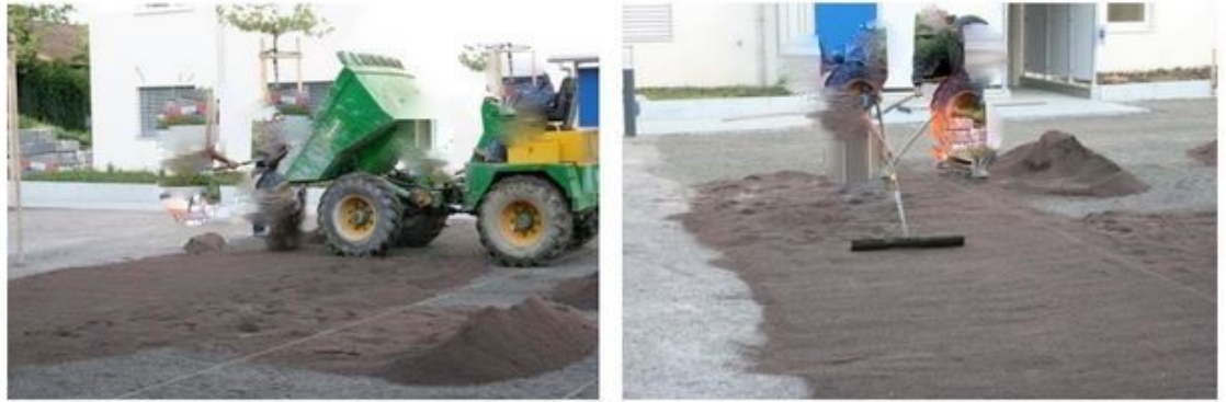
Kuva 6. Käsintapahtuva asennus (Stabilizer Solutions, 2008.)
