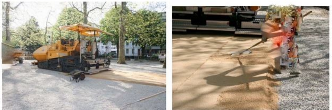
Kuva 5. Koneellinen asennustapa (Stabilizer Solutions, 2008.)
