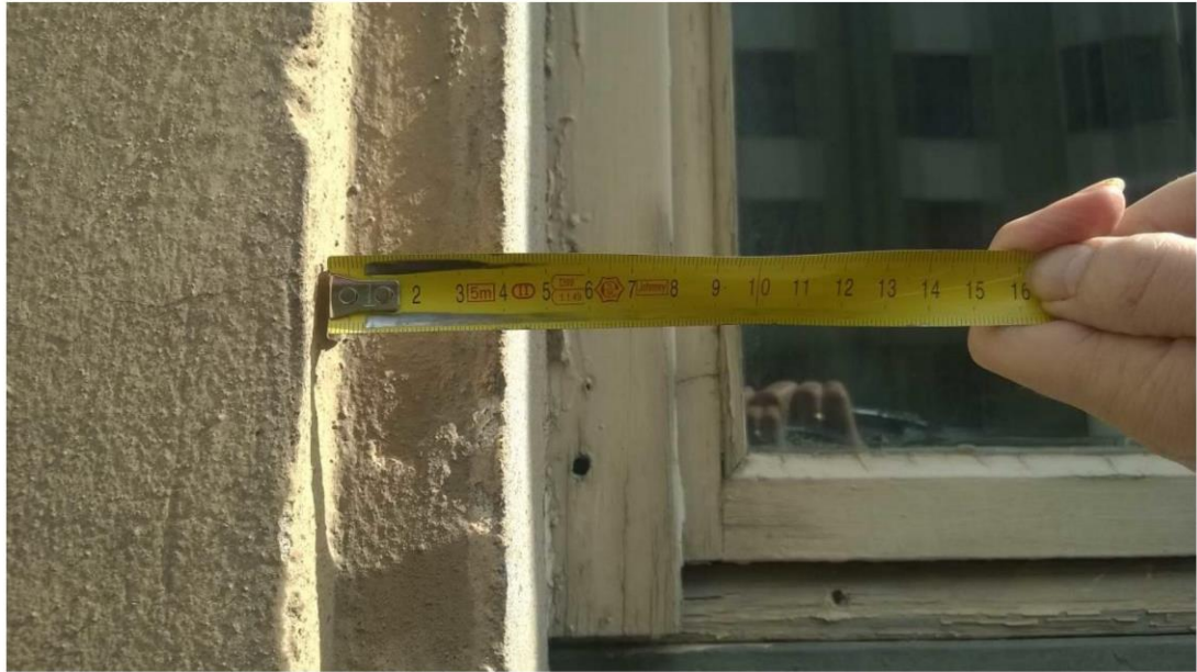
Kuva 8: Nykyisen pielen ja harkkorappauksen väli on 4 cm.
