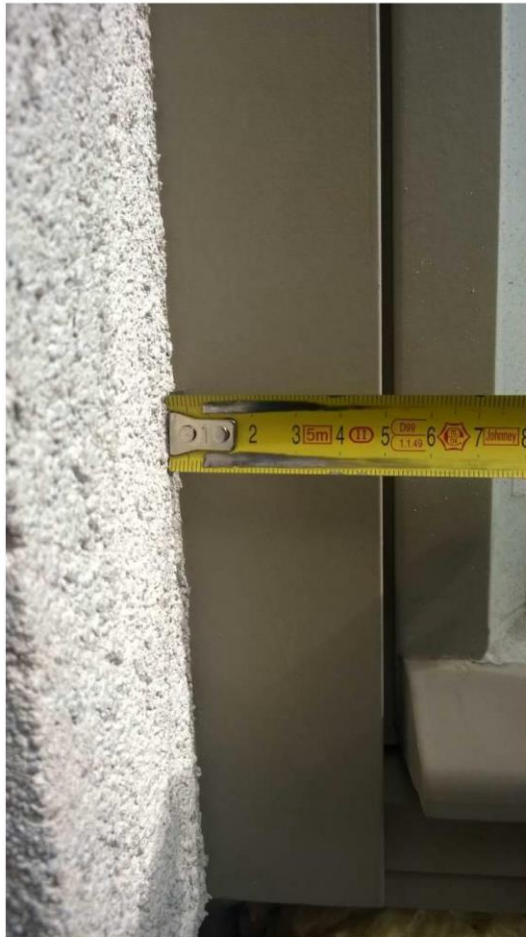
Kuvat 6 ja 7: Vasemmalla uusittu ikkuna, oikealla nykyinen (ei alkuperäinen) ikkuna. Nykyisen ikkunan karmi näkyvissä 5 cm ja malli-ikkunan samoin 5 cm → ok.
