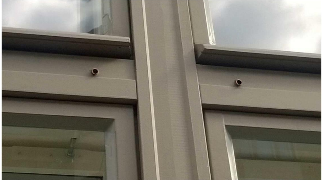
Kuva 10: Malli-ikkunan pystyjakokarmin ja vaakajakokarmin liittymä.
