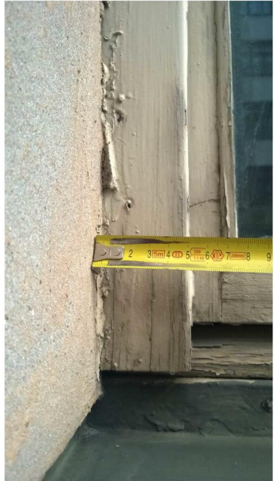
Kuvat 6 ja 7: Vasemmalla uusittu ikkuna, oikealla nykyinen (ei alkuperäinen) ikkuna. Nykyisen ikkunan karmi näkyvissä 5 cm ja malli-ikkunan samoin 5 cm → ok.
