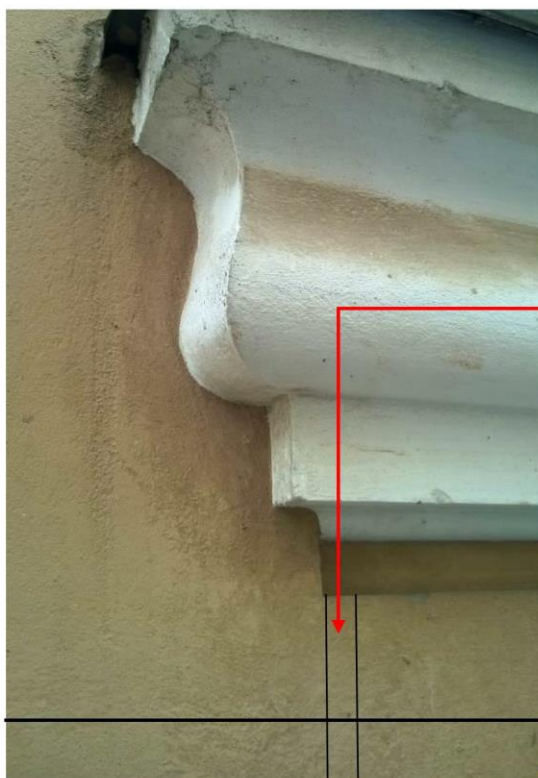
Kuvat 9 ja 10: Pentti Pietarila on ohjeistanut, että tähän kohtaan rappaukseen tehdään pystysuuntainen varjoura, johon harkkokerroksen väri Facade 4960 listan alla päätetään.
