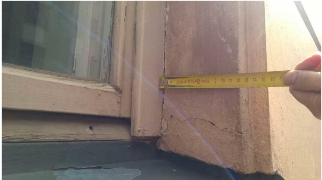
Kuva 3: nykyinen ikkunapielen leveys 12 cm
