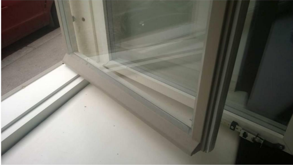
Kuva 12: Malli-ikkunan ulkopuolen väri on suunnitelmien mukainen: Tikkurila Symphony K486, vaaleanrusehtavanharmaa. Samalla värillä tulevat myös ikkunavesipellit. Ikkuna- ja ikkunavesipeltiväri hyväksyttiin.
