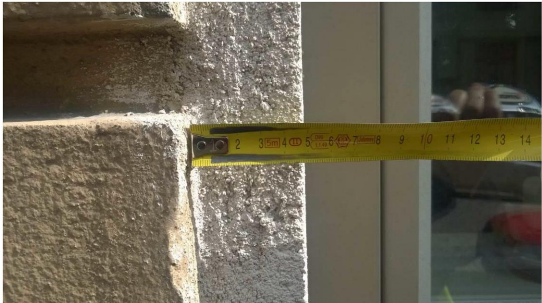
Kuva 9: Malli-ikkunan pielen ja harkkorappauksen väli 5 cm.
