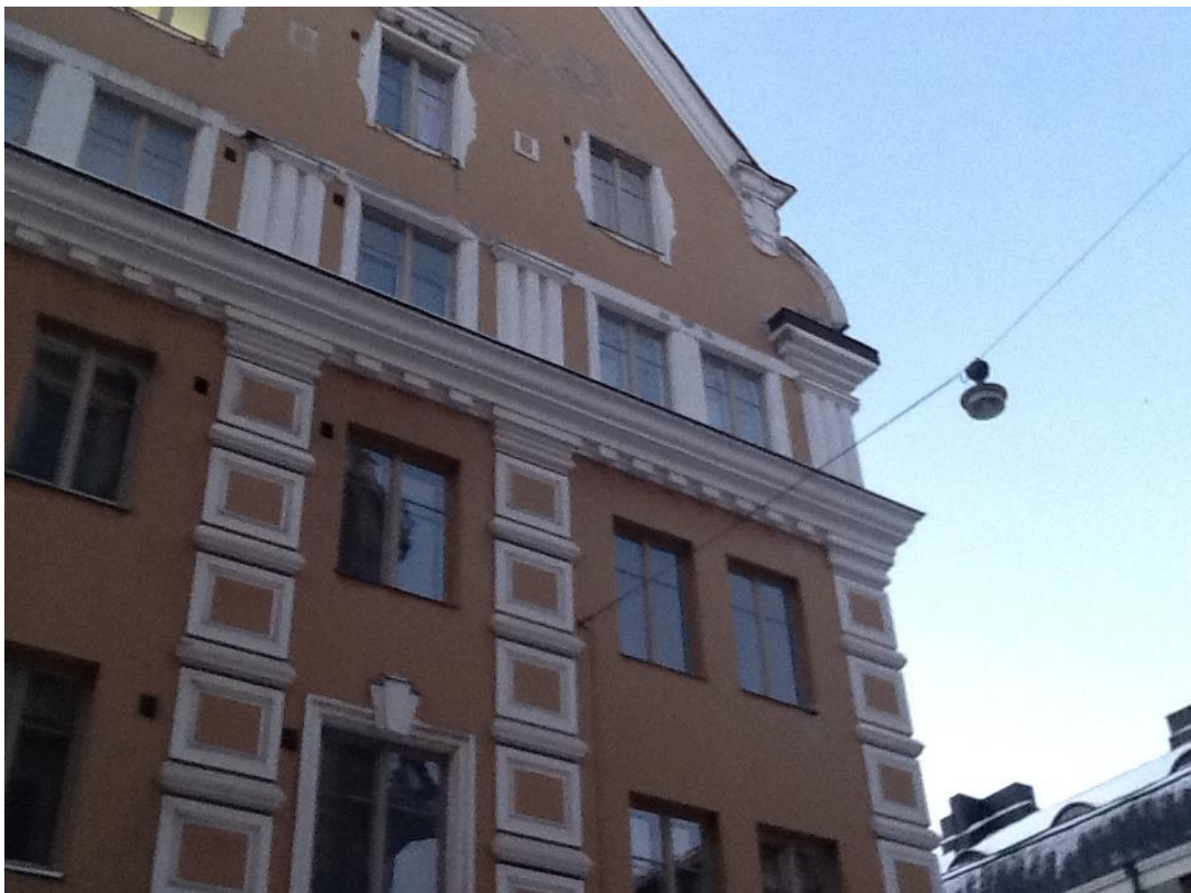
Kuva 4. As Oy Aedificiumin katujulkisivu Oikokadun puolelta ennen töiden aloitusta.
