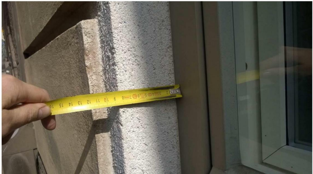
Kuva 4: Malli-ikkunan ikkunapielen leveys hiukan yli 8 cm.
