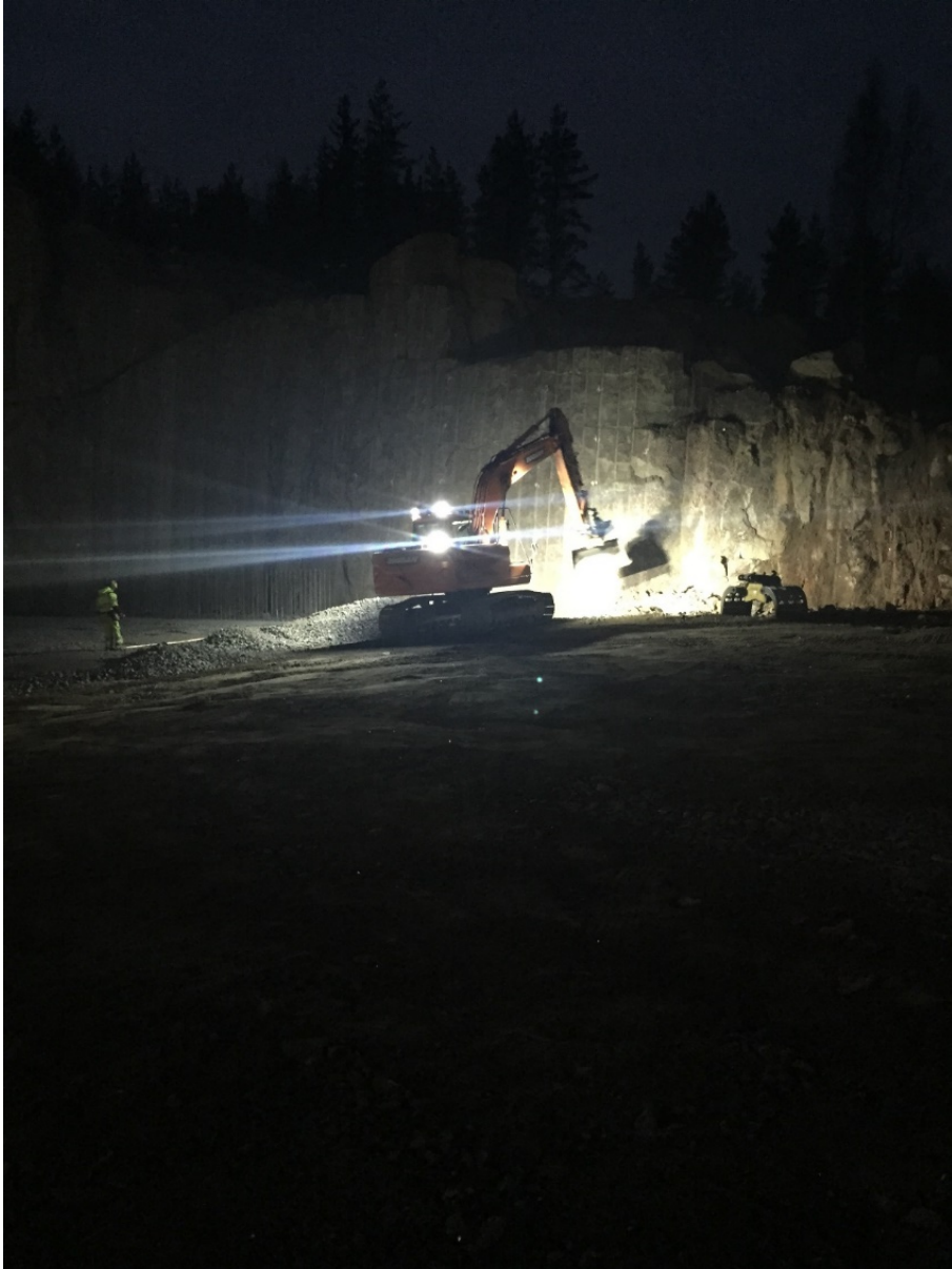
Kuva 11. Työkoneen valaistus E18 Hamina-Vaalimaa tietyömaalla
