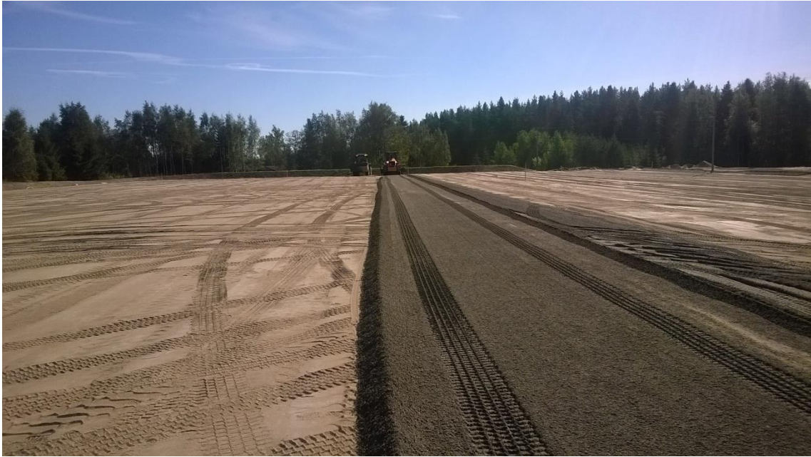
KUVA 4. 30 mm kivituhkan levitys koneohjauksella
