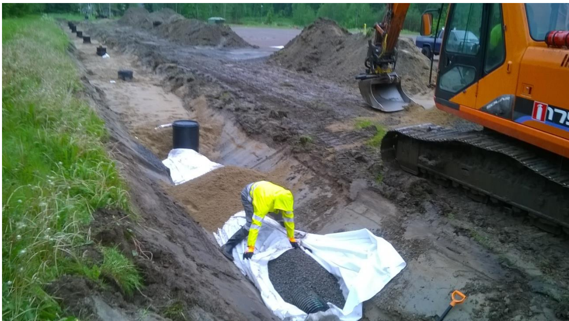
KUVA 2. Runkoputken asennustyö
