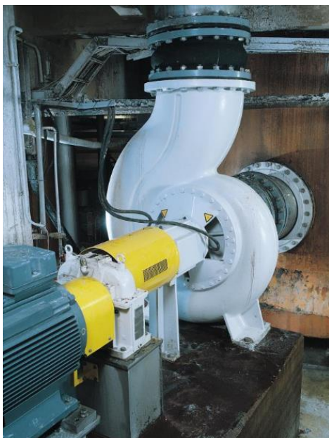
Kuva 6. Ahlstar W. Kulutusta kestävä yksijaksoinen keskipakopumppu (18)
