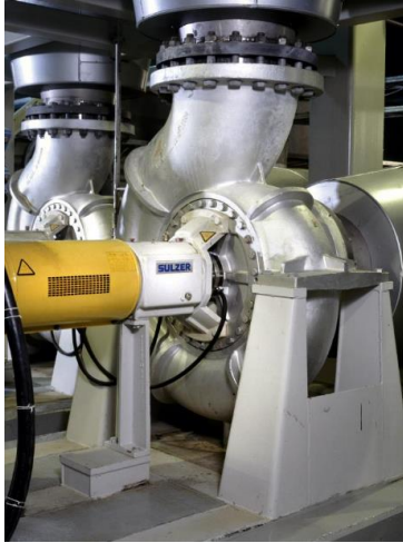
Kuva 7. Ahlstar E. Keskiosastaan tuettu kuumien nesteiden pumppaamiseen soveltuva yksijaksainen keskipakopumppu (19)
