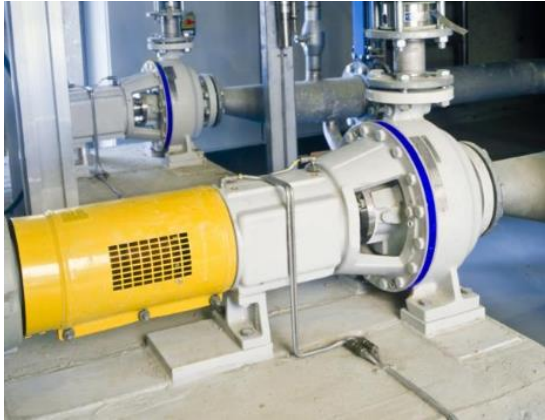
Kuva 5. Ahlstar N. Tukkeutumaton yksijaksoinen keskipakopumppu (17)
