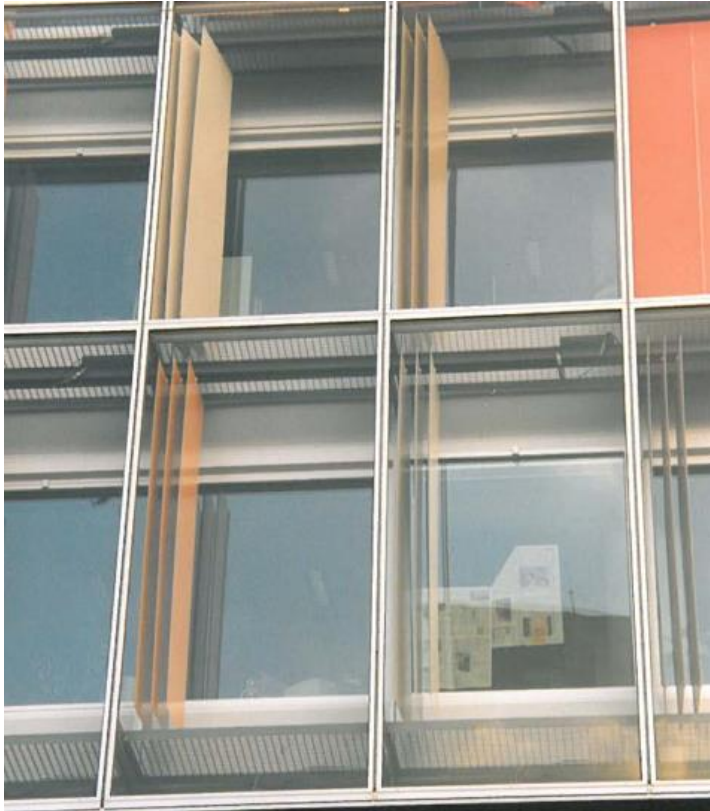
Kuva 3. Kaksoisjulkisivu Berliinissä, jossa näkyy hyvin huoltosillat joka kerroksessa, sekä kaihtimet.
