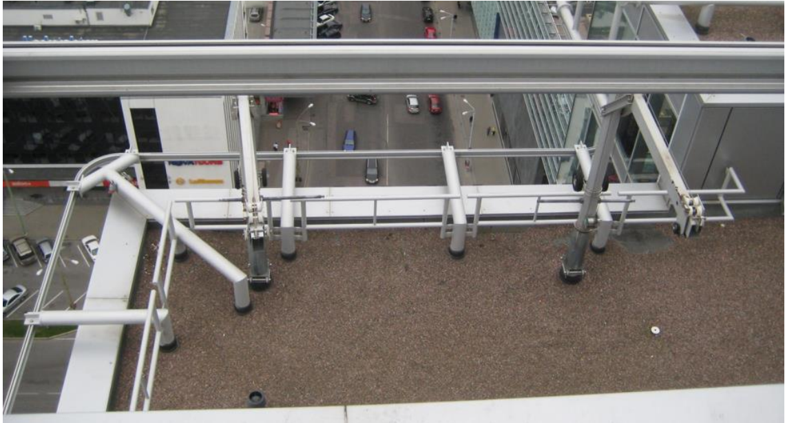
Kuva 10. Huoltokorin kiskot rakennuksen vesikatolla.
