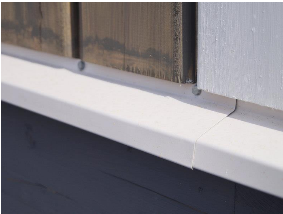
Kuva 4. Tippapelti hirsiseinän alapäässä. (Pystyhirsi.fi, [viitattu 9.2.2017].)
