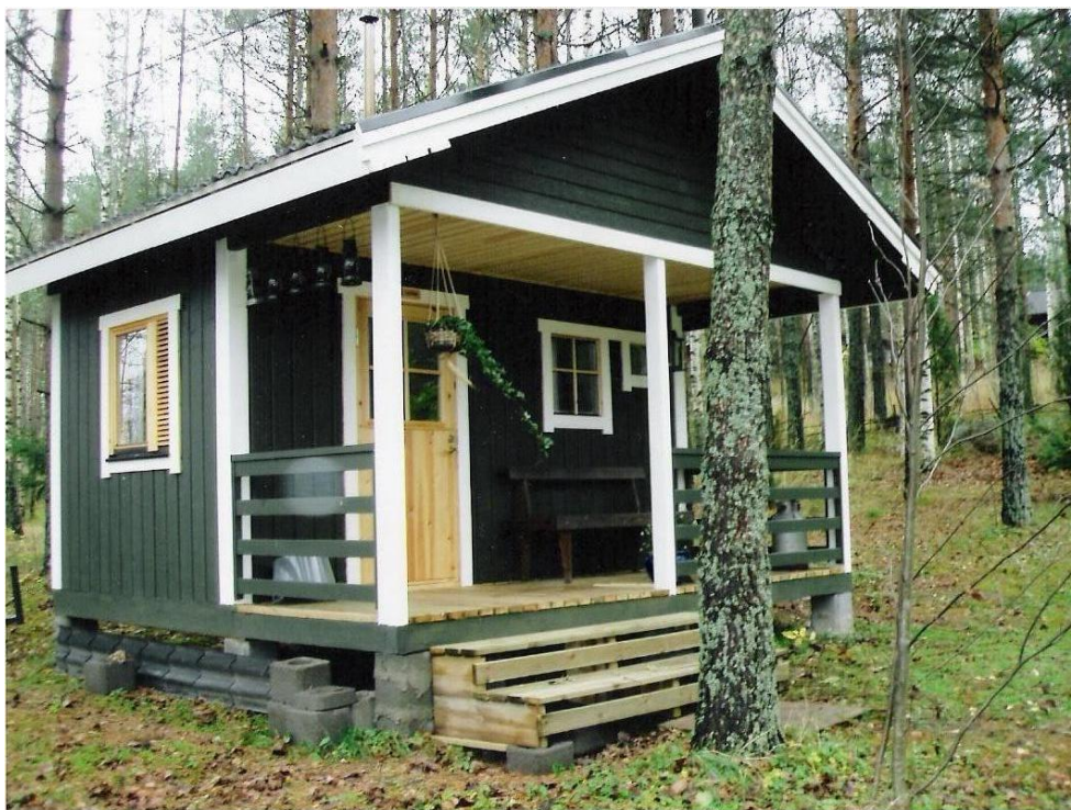
Kuva 10. Pystyhirrestä tehty pihasauna.
