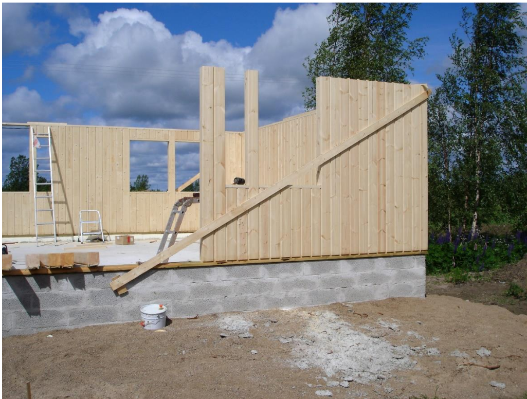
Kuva 6. Rakenteilla oleva pystyhirsikehikko.
