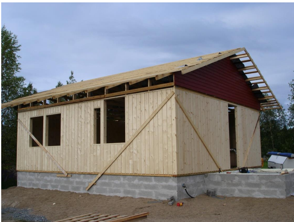
Kuva 9. Rakenteilla oleva pystyhirsinen pientalo.
