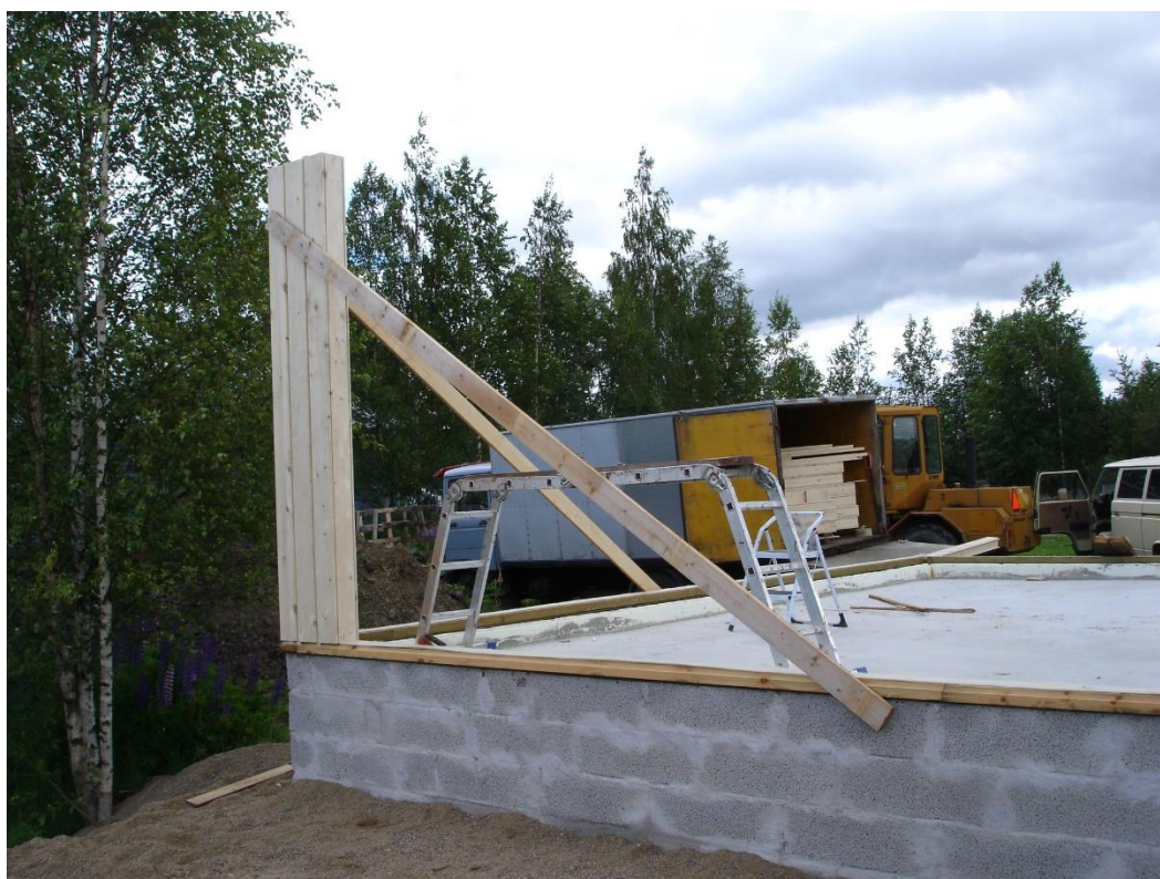
Kuva 5. Seinän pystytyksen aloitus nurkasta.
