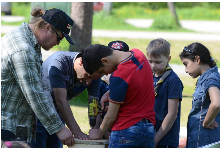
KUVA 8. Linnunpöntön rakennusvaihe (Kauppinen 2016-05-29.)
