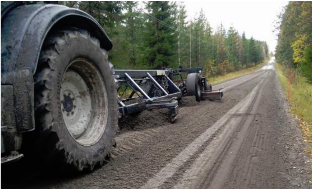
Kuva 25. Sideaineen sekoittamista tierakenteeseen. (Nurminen 2016-09-30)
