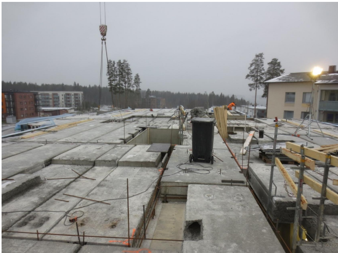
KUVA 3. Ontelolaatasto asennettuna 2015-01-11 (Kuparinen)
