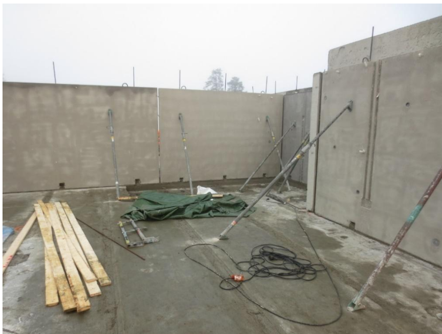
KUVA 2. Seinäelementtien asennuksen jälkeinen tuenta 2014-12-05 (Kuparinen)
