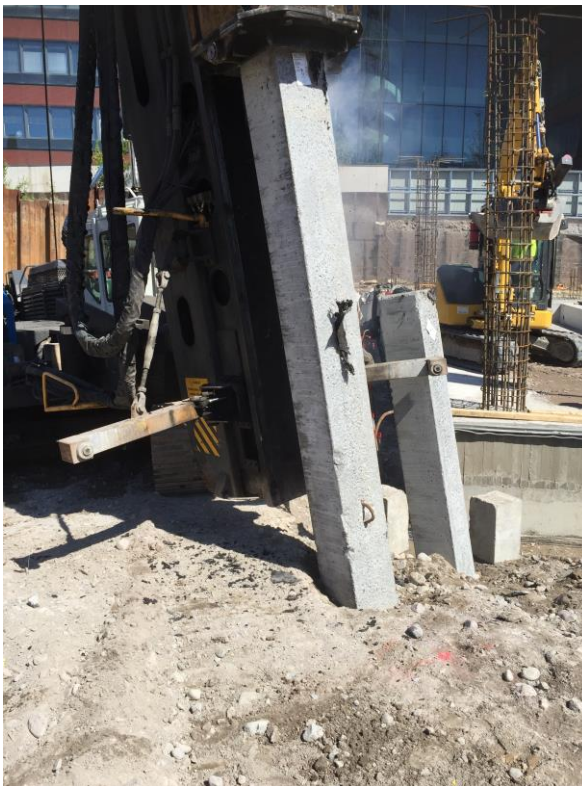
Kuva 24. Nylatron-iskutyyny käytössä
