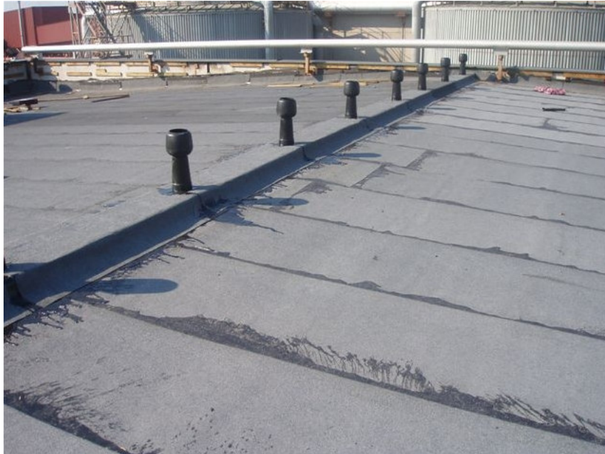
Kuva 30. Konesalin märänpään uusittua kattoa.
