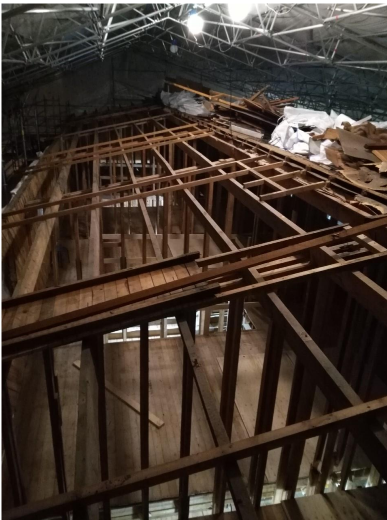
KUVA 6. Vesikaton purkua sääsuojan alla.
