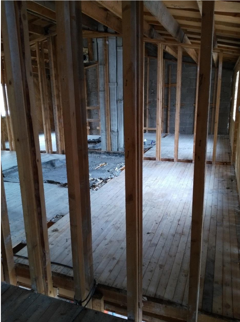
KUVA 2. Siivousta ja asbestipurkua vaille valmis yläkerta. Kuvassa näkyy huoneistojen välisten seinien runkorakenne.
