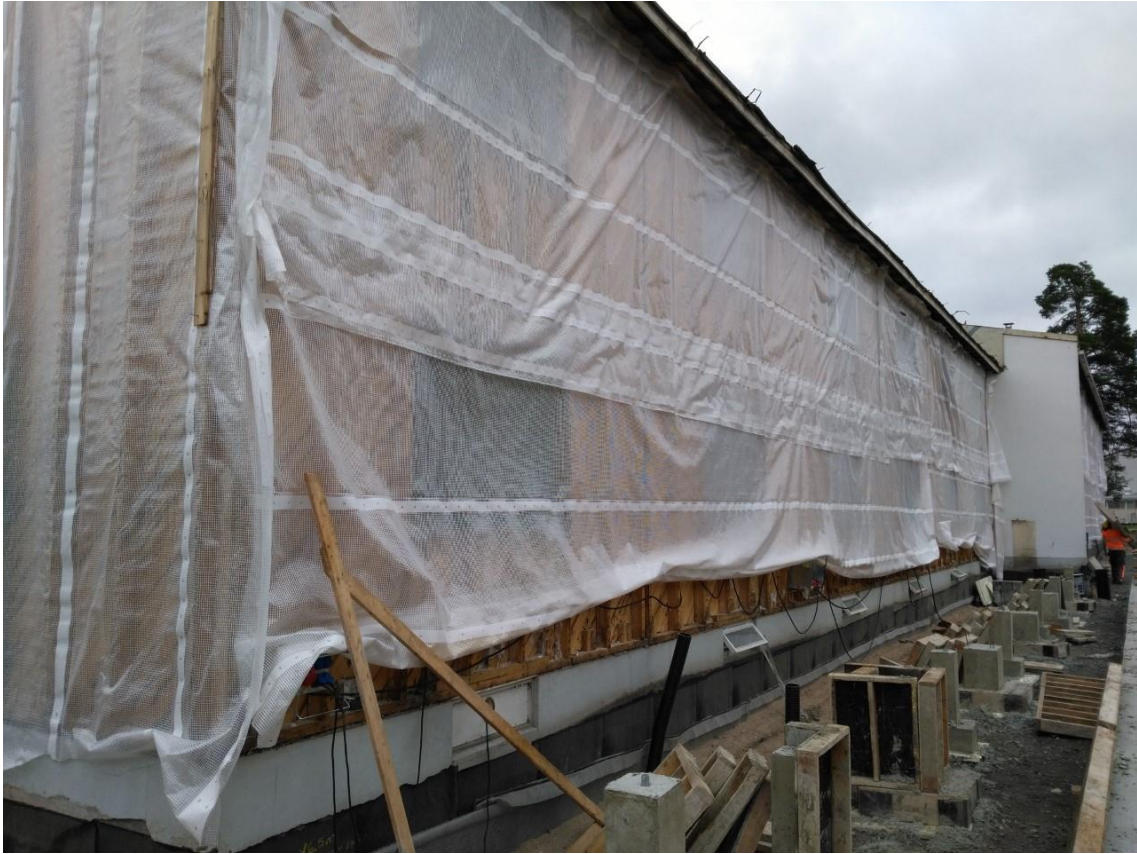
KUVA 5. Kuvassa valmiiksi purettu julkisivu ja suojaus.
