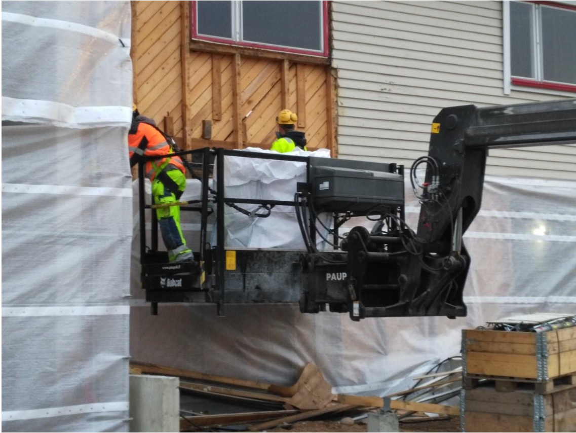
KUVA 4. Julkisivun purkua ja suojausta.
