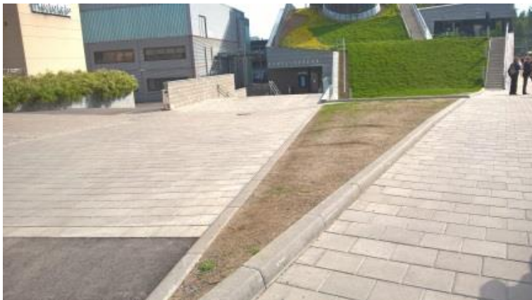
Kuva 16. Tietotalon edustan nurmikoroke keskellä kulkuväylää (Mäkiselkä 2016)
