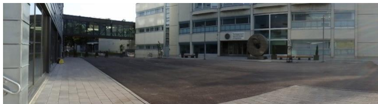
Kuva 9. Päärakennuksen pääsisäänkäynti (Mäkiselkä 2016)
