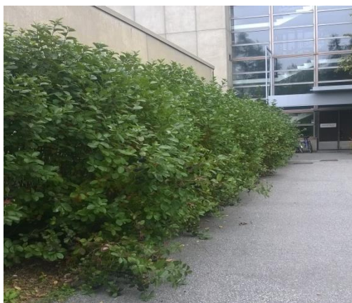
Kuva 19. A-sisäänkäynnin valaisimet peittävä pensasryhmä (Mäkiselkä 2016)
