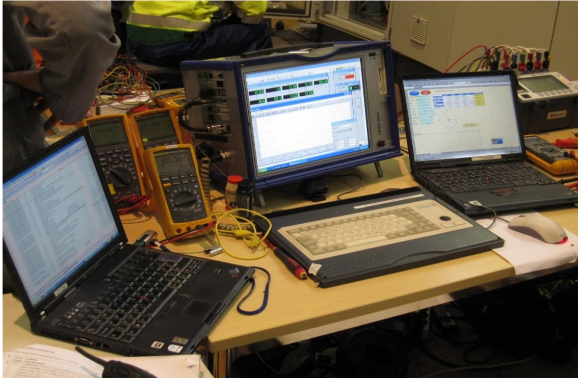
KUVA 10. Magnetoinnin käyttöönottokoestuksen mittausjärjestelyt
