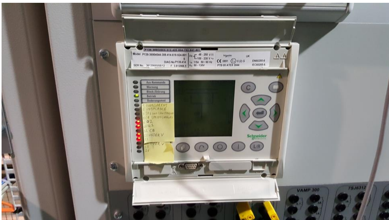
Figur 1. MiCOM P139 överströmskyddrelä i DEMVE.
