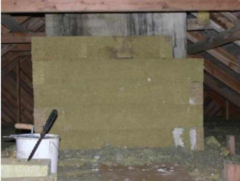
Kuva 7. Levyjen asettelu limittäin saumat eri kohtiin (Paroc)
