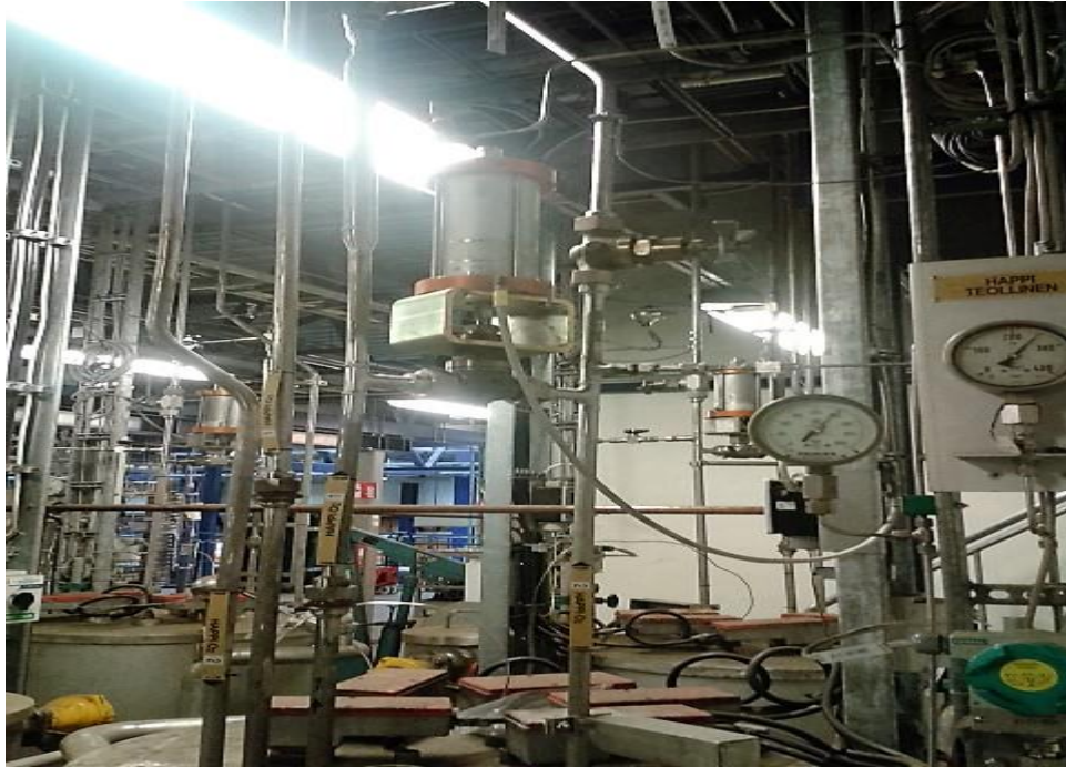
Kuva 15. Teollinen happi muutostyö sekä muut asennustyöt valmiina (Lindfelt 2016)
