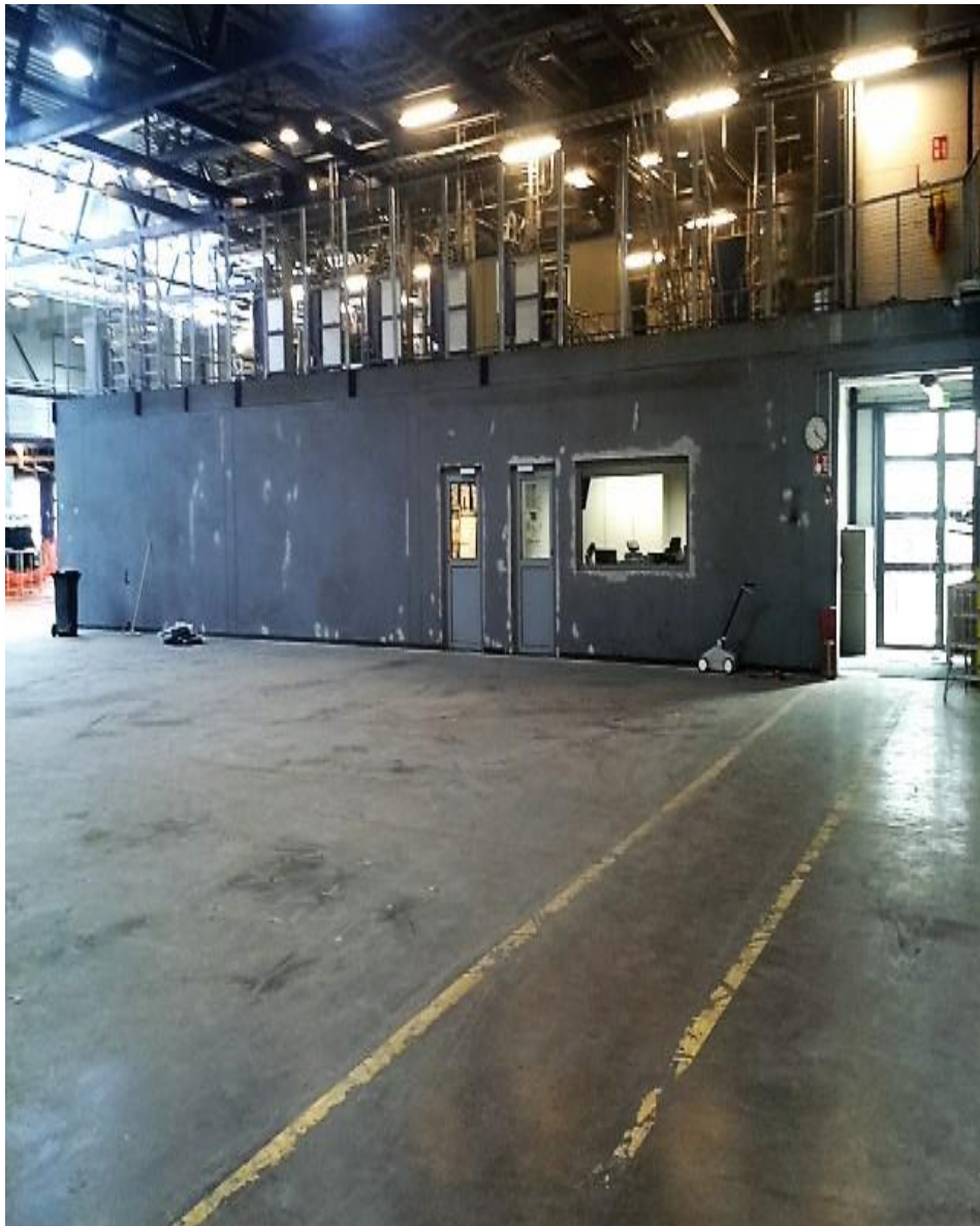
Kuva 18. Purettu täyspullovaraston robottialue ennen lattian pinnoitustöitä (Lindfelt 2016)
