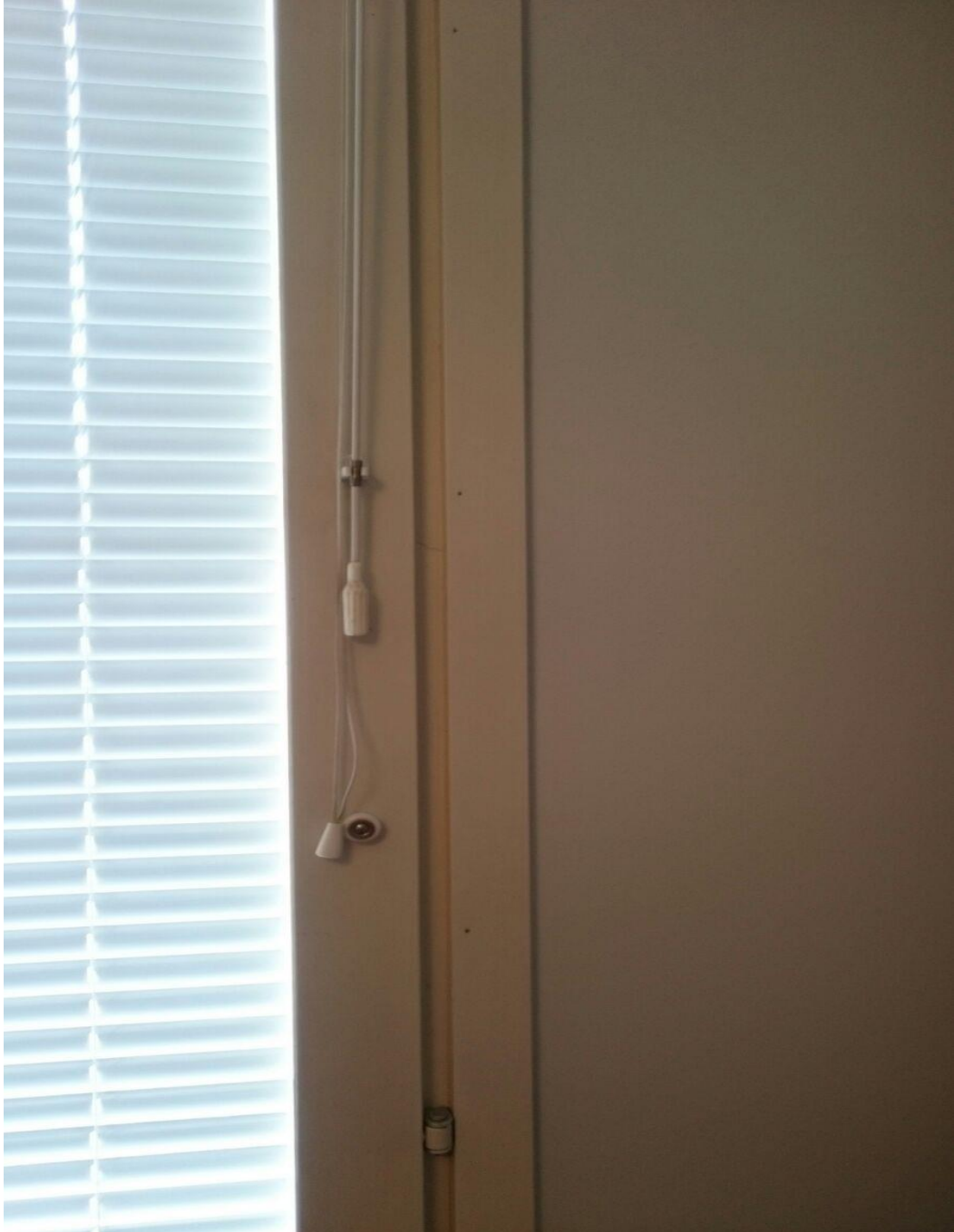
Kuva 9. Perinteisen sälekaihtimen säätö narujen ja vaijerin avulla.
