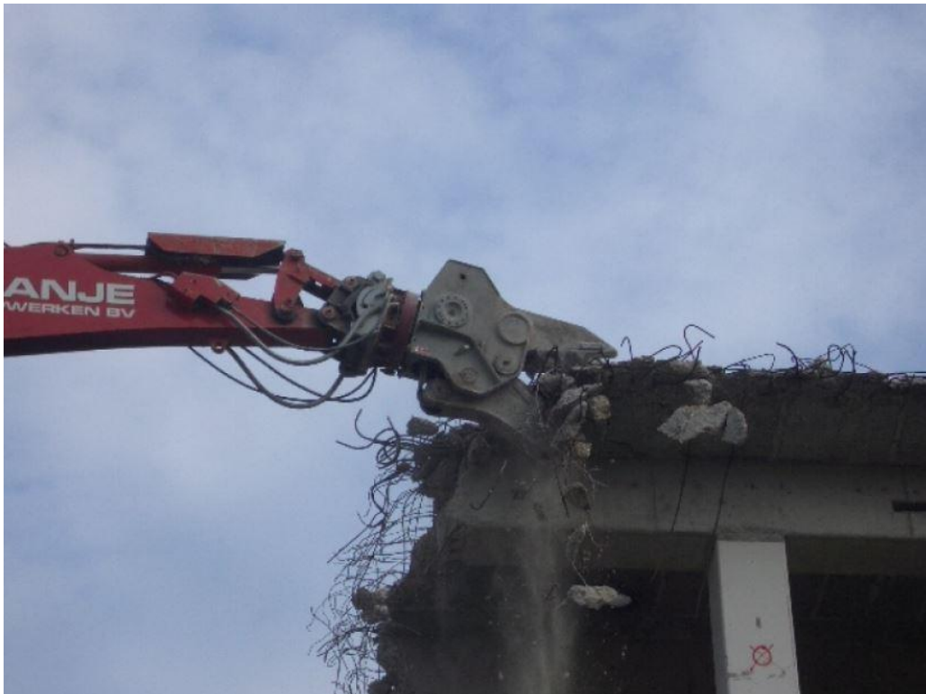
Kuva 12. Hydraulinen pulveroiva purkukoura. (Demolition and Recycling Equipment, 2017.)
