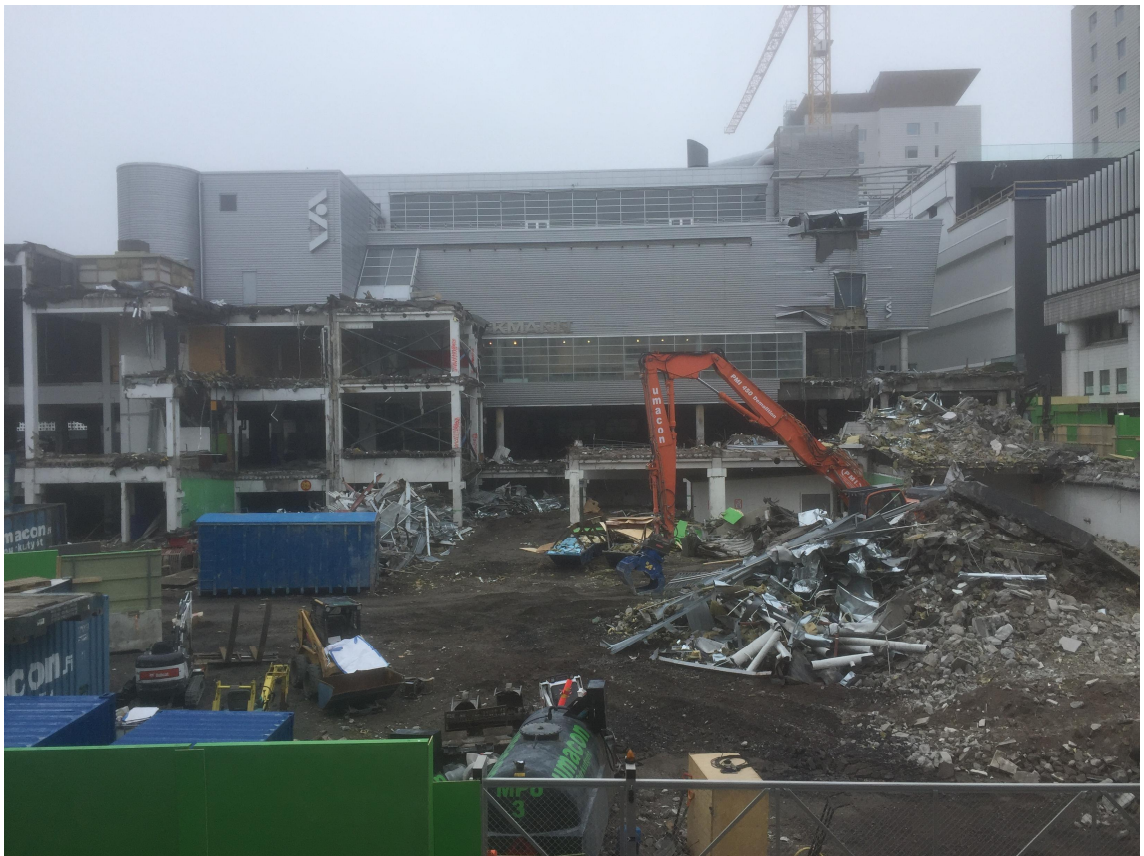
Kuva 2. Tyypillinen näkymä purkutyömaalta, kuva otettu Tapiolasta huhtikuussa 2017.
