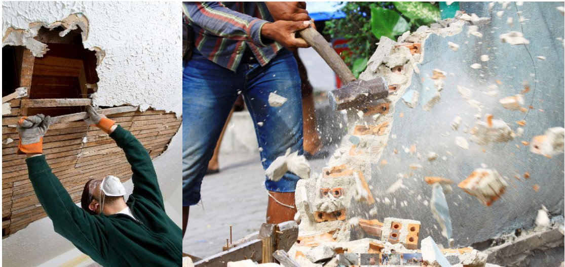
Kuva 8. Perinteistä purkua käsityönä. (Kuljetusliike Aaltonen Oy, 2017.) (Delprete Masonry Inc., 2017.)
