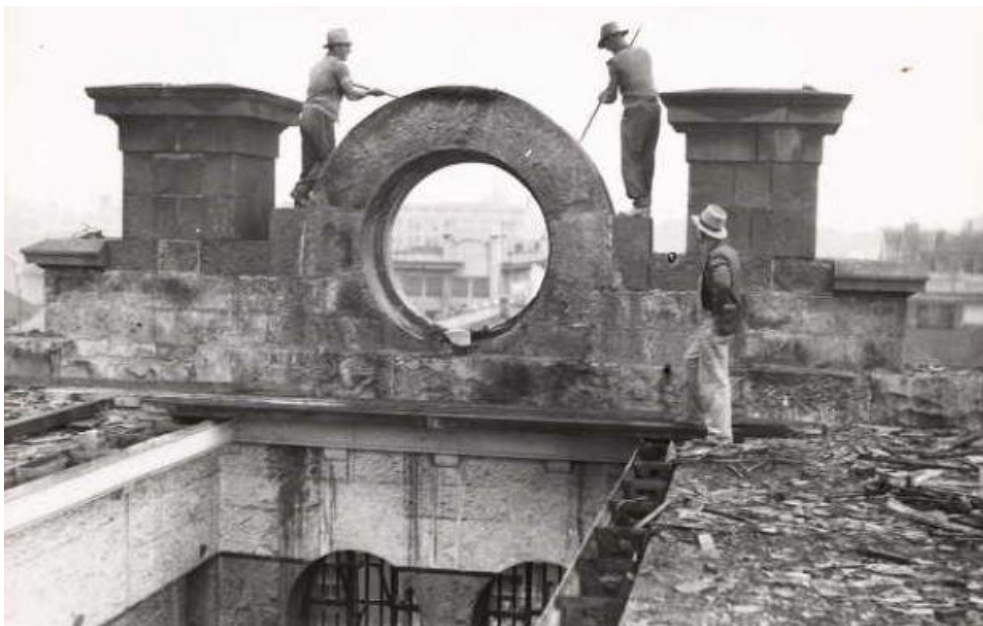
Kuva 9. Purkutyötä Australiassa v.1937. (Wikipedia, 2017.)
