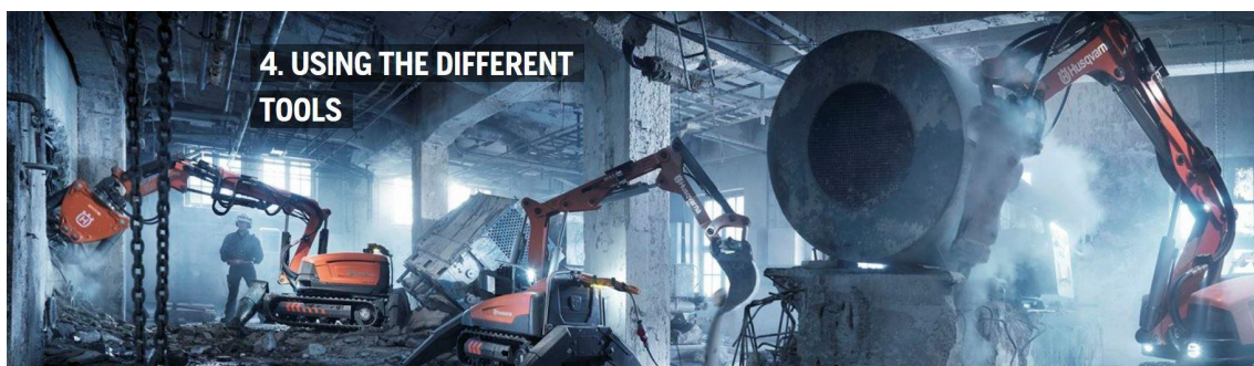
Kuva 16. Etäpurkulaitteita teollisuuskohteessa. (Husqvarna AB, 2017.)
