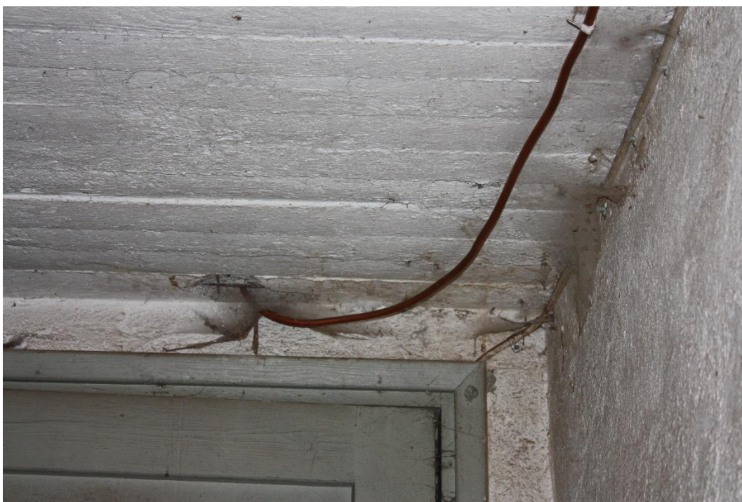
Kuva 72. Käyttövesiputki kellarissa.
