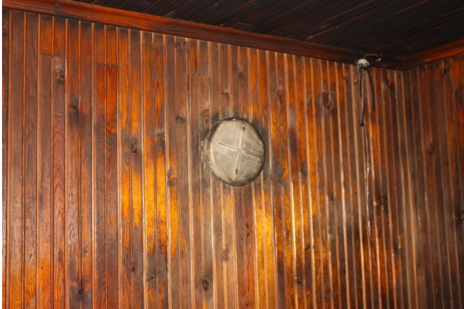
Kuva 43. Saunan korvausilmaventtiili
