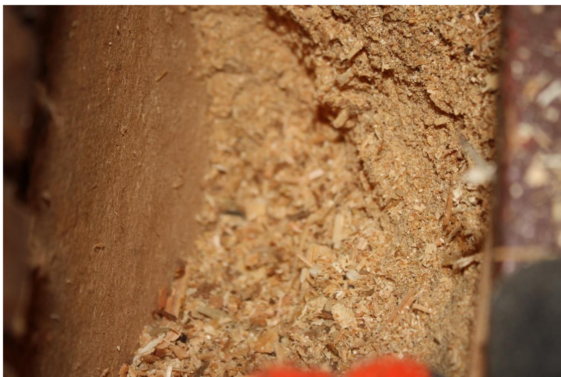
Kuva 42. Pukuhuoneen lattian purueristeet vaikuttivat kuivilta.
