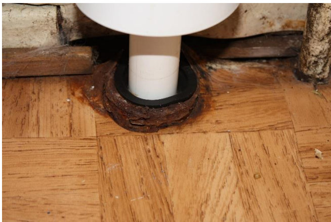
Kuva 50. WC:n lavuaarin viemäri.
