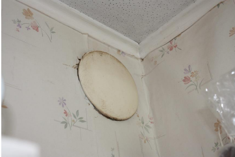
Kuva 55. Keittiön poistoilmaventtiili.
