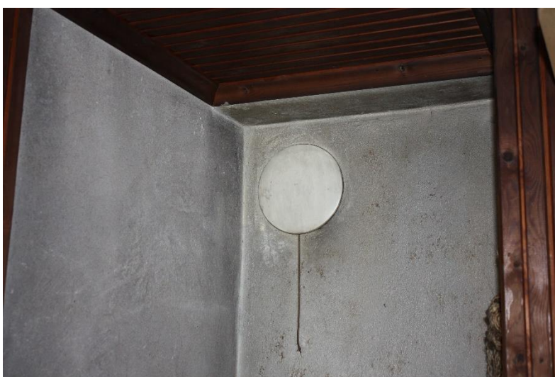
Kuva 41. Pukuhuoneen poistoilmaventtiili
