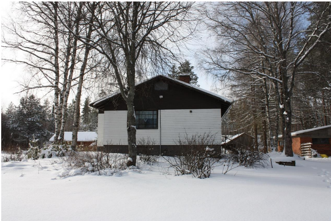
Kuva 31. Runsaasti lehtipuita rakennuksen välittömässä läheisyydessä.
