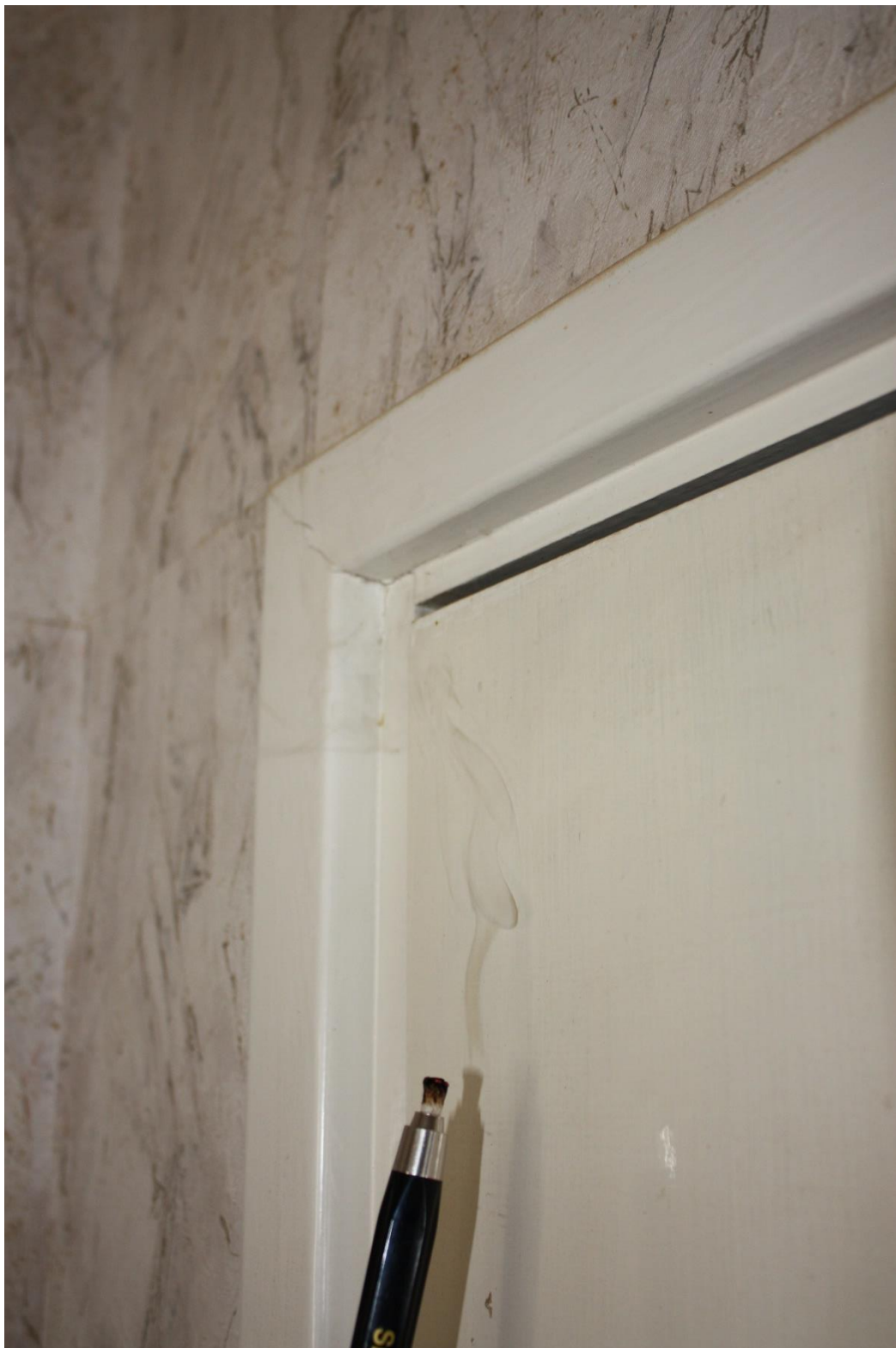
Kuva 3. Merkkisavukokeessa ei huomattu ainakaan mitään suurempia ilmavirtauksia kellarin oven saumoista. Oven saumat on tiivistetty hiljattain, ettei kellarin mahdollisesti saastunut ilma kulkeutuisi asuintiloihin.
