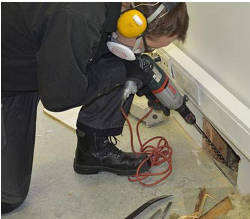
Kuva 12. Rakenteiden avausta lattian ja seinän liitoskohdasta.(27)
