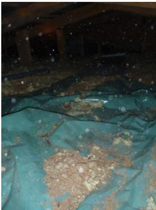
Kuva 8. Eristeiden päällä olevan muovikalvon alla on suuri mikrobivaurion riski.(7)
