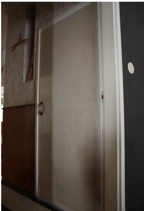
Kuva 40. Yläpohjaan vievä ovi.
