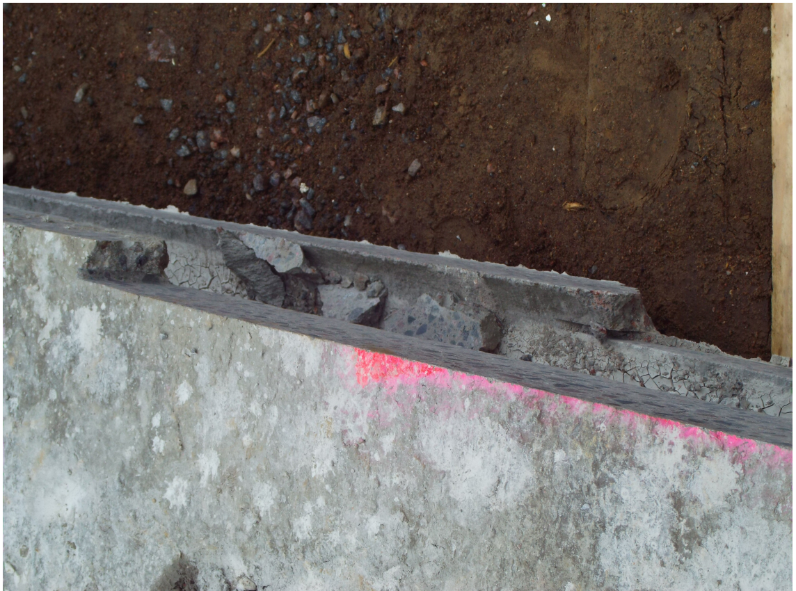
Kuva 10. Leikattu ontelolaatta, joka toimitettu työmaalle.
