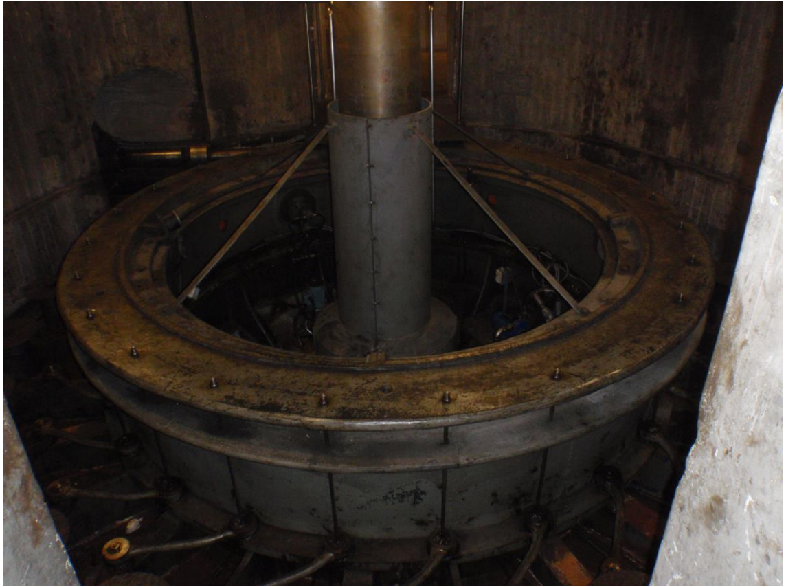
KUVA 5. Säätörengas ja vivusto
