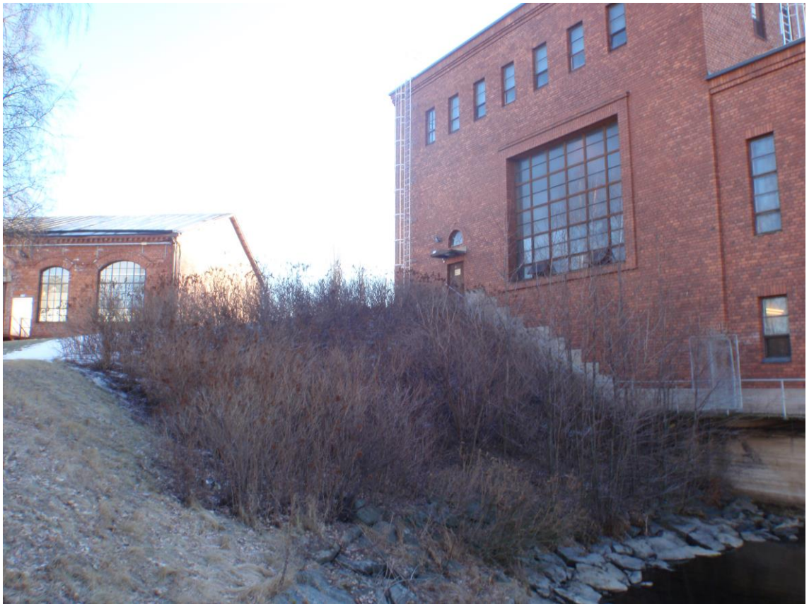
KUVA 13. Näkymä laitoksen paperitehtaan puolelta. Rinteen keskikohdassa näkyy iso ikkuna, jonka kautta voi mahdollisesti kuljettaa osia laitoksen sisään.
