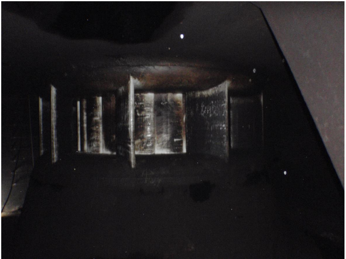
KUVA 2. Johtopyörä solukkeet kiinni. Tukiraudat näkyvät ulkolaidoilla.
