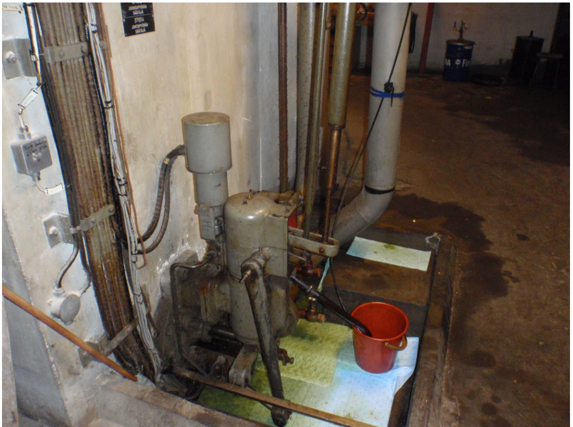
KUVA 20. Servosylinteri ja sen perässä oleva öljynjakopesä, josta lähtee säätötangot akselille, joka on kiinni säätäjässä.
