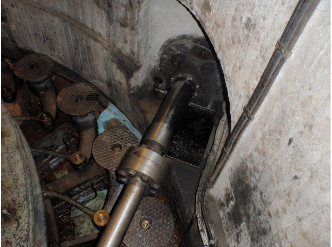
KUVA 7. Servosylinteri, servosylinterin työntötanko ja vivusto
