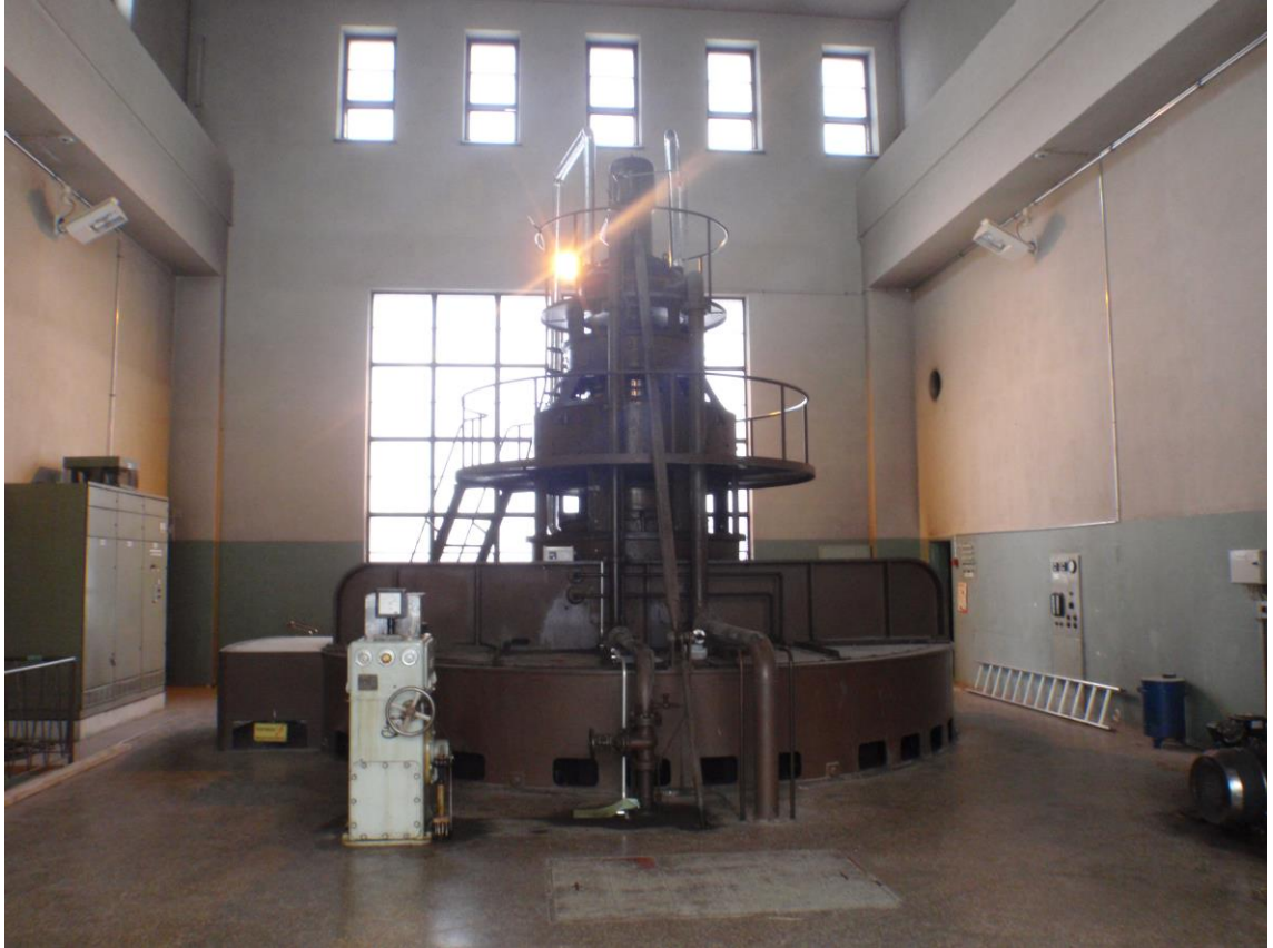
KUVA 16. Säättäjä ja generaattorirunko, jonka huipulla on kombinaattori.
