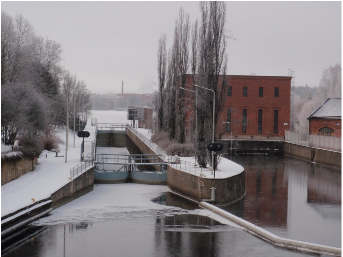
KUVA 11. Valkeakosken vesivoimalaitosrakennus oikealla ja vasemmalla kanava
