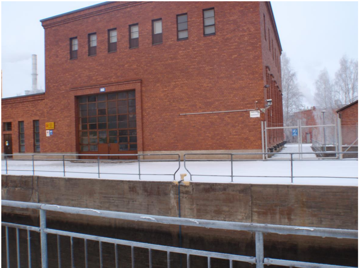
KUVA 12. Näkymä laitoksen pääovista kanavan toiselta puolelta.
