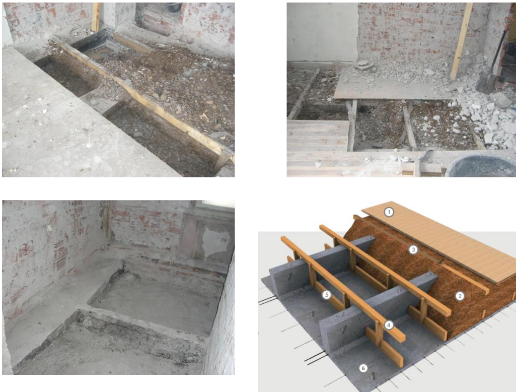
Kuvat 20. Työmaa-aikaisia valokuvia kohteesta ja suunnittelijan näkemys tilanteesta
