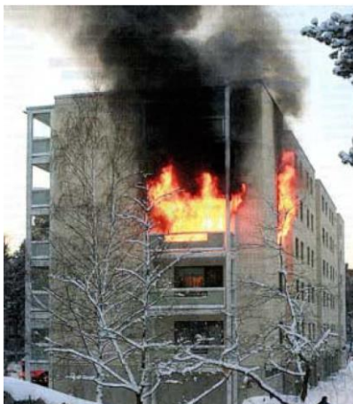
Kuva 23. Todellinen tulipalo ja palamaton julkisivu, huonepalosta uloslyövät liekit (Mellunmäki, Helsinki 22.1.2006) [kuva: Antti Kiiski]. /44./
