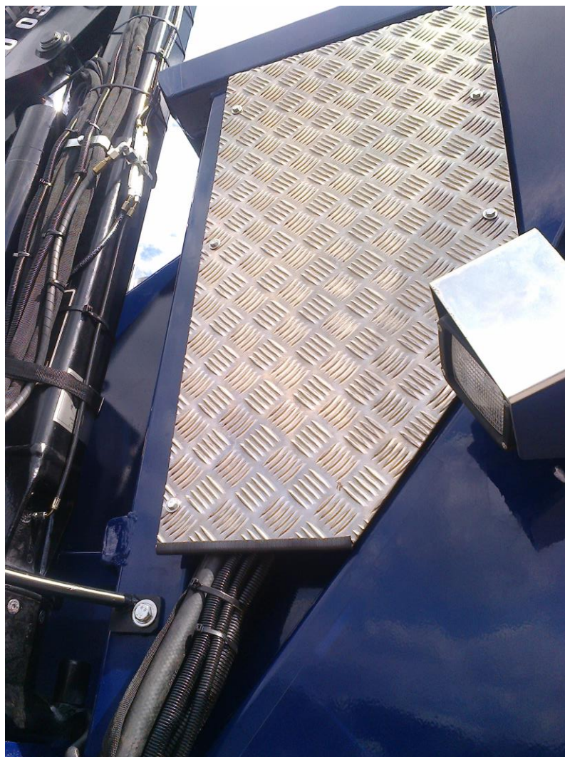
KUVA 25. Letkujen ja johdotusten suojus
