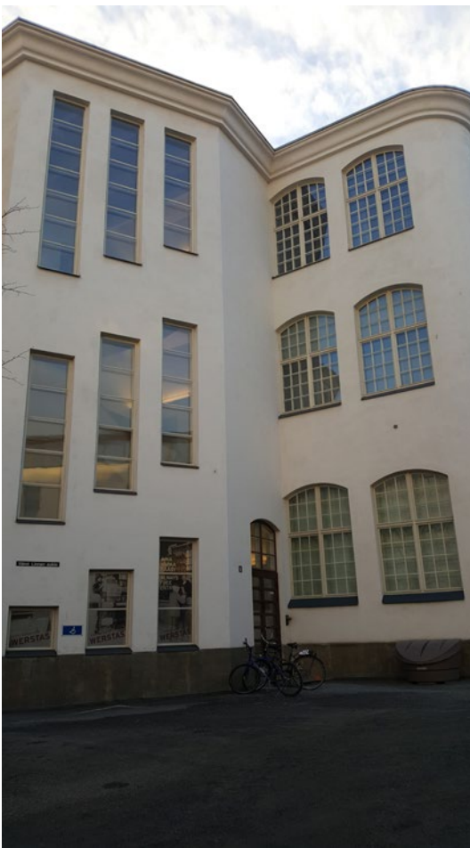
Ulkorakennus (Työväenmuseo Werstaan julkisivu), jonka skannausta testasin.
