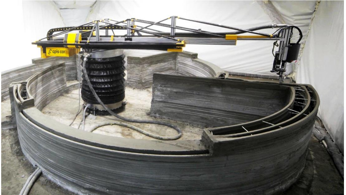
Kuva 5 Apis Cor-yrityksen rakennus tulostusvaiheessa (Rainisto 6.3.2017)
