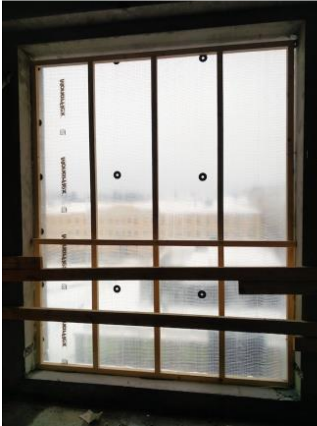
Kuva 16. Kasarmikatu. Säsuojaelementti ikkuna-aukossa.
