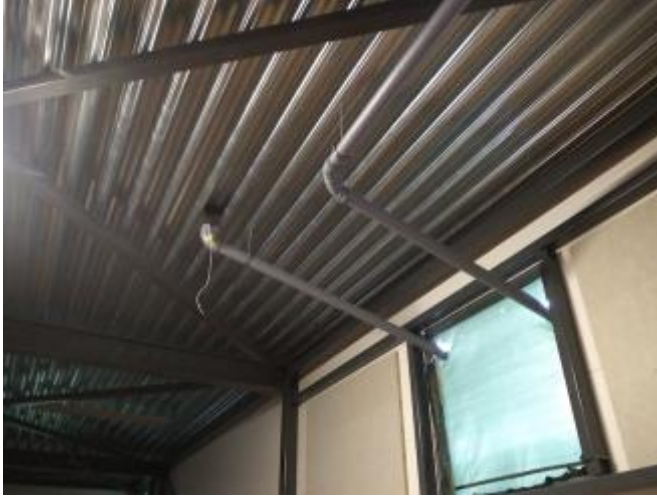
Kuva 13. Business Park. Väliaikaiset kattokaivojen väliaikaiset viemärit.
