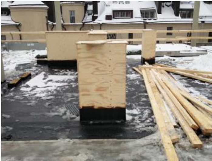
Kuva 15. Kasarmikatu. Talotekniikkakuilun suojaus bitumikermillä ja laatikot riittävää putkinousua varten.
