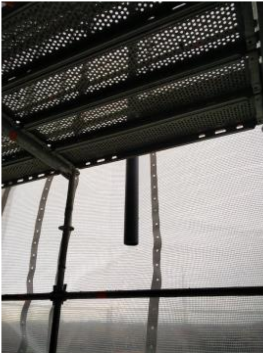
Kuva 14. Business Park. Väliaikaisen viemärin syöksyputki, joka olisi voinut olla pidempi.
