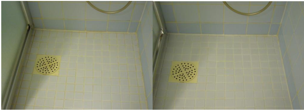
Kuvat 3 ja 4: Kylpyhuoneen suihkun puoli ennen peruspesua (vasemmalla) ja peruspesun jälkeen (oikealla)
