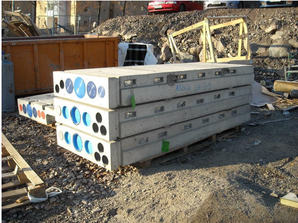
Kuva 1. Luja-hormielementtejä työmaalla
